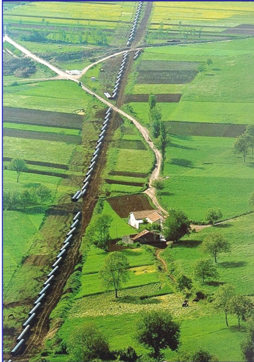
Figura 2.6.3/3 - Sfilamento tubazioni
