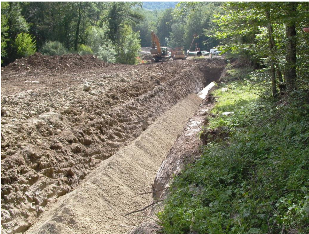
Figura 2.6.3/7 - Rinterro della condotta
