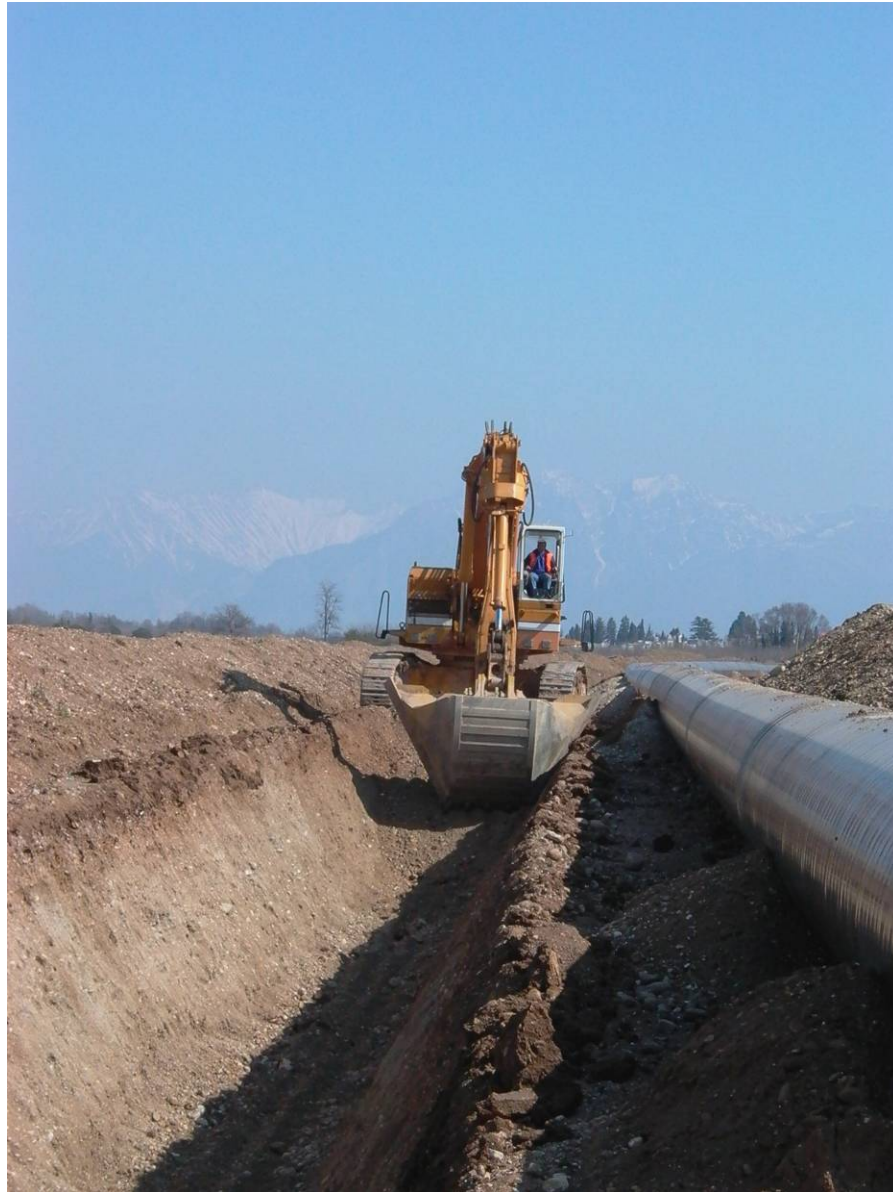
Figura 2.6.3/5 - Scavo della trincea
