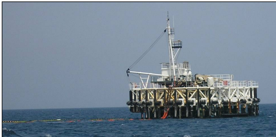
Figura 2.2.1/3 - Attuale piattaforma SPM (Single Point Mooring) operativa al largo di Falconara Marittima
