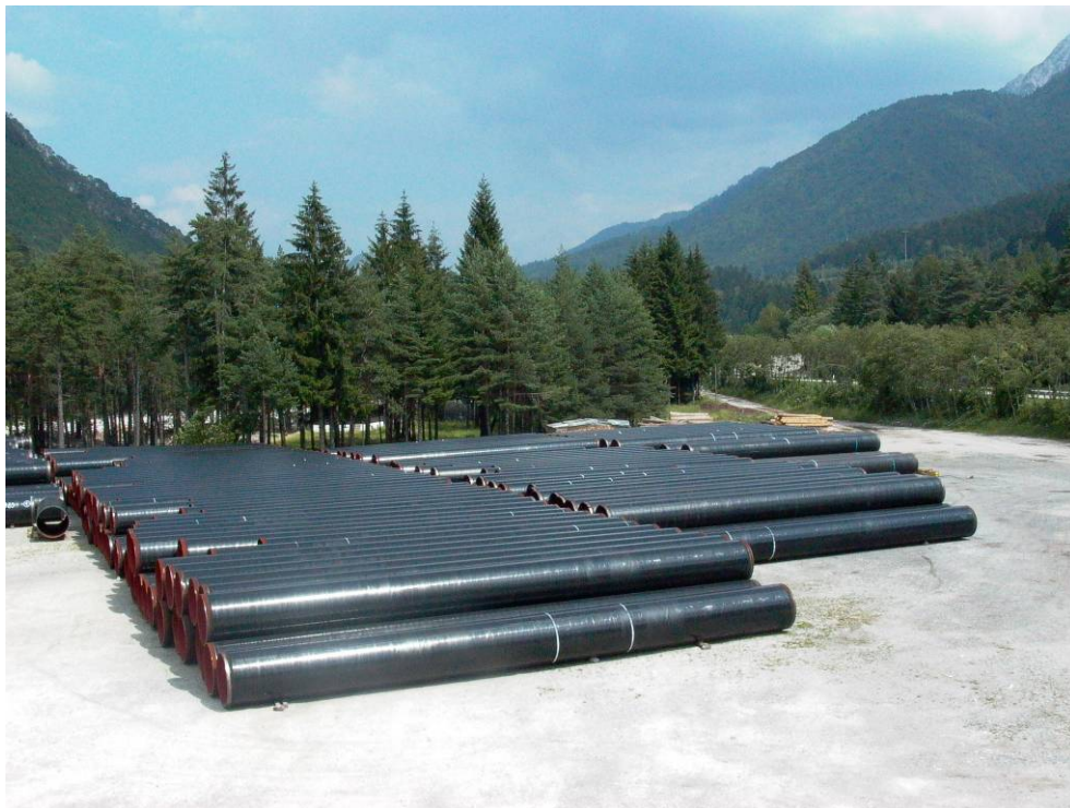
Figura 2.6.3/1 - Piazzola di accatastamento tubazioni
