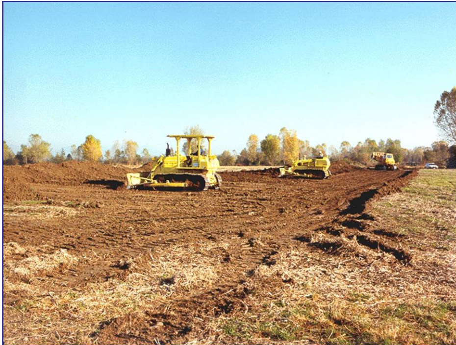
Figura 2.6.3/2 - Apertura dell'area di passaggio
