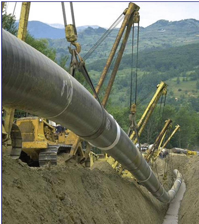
Figura 2.6.3/6 - Posa della condotta
