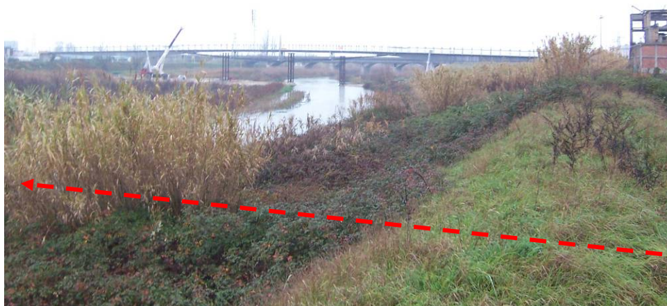
Foto 7 – Attraversamento in trivellazione del Fiume Esino
