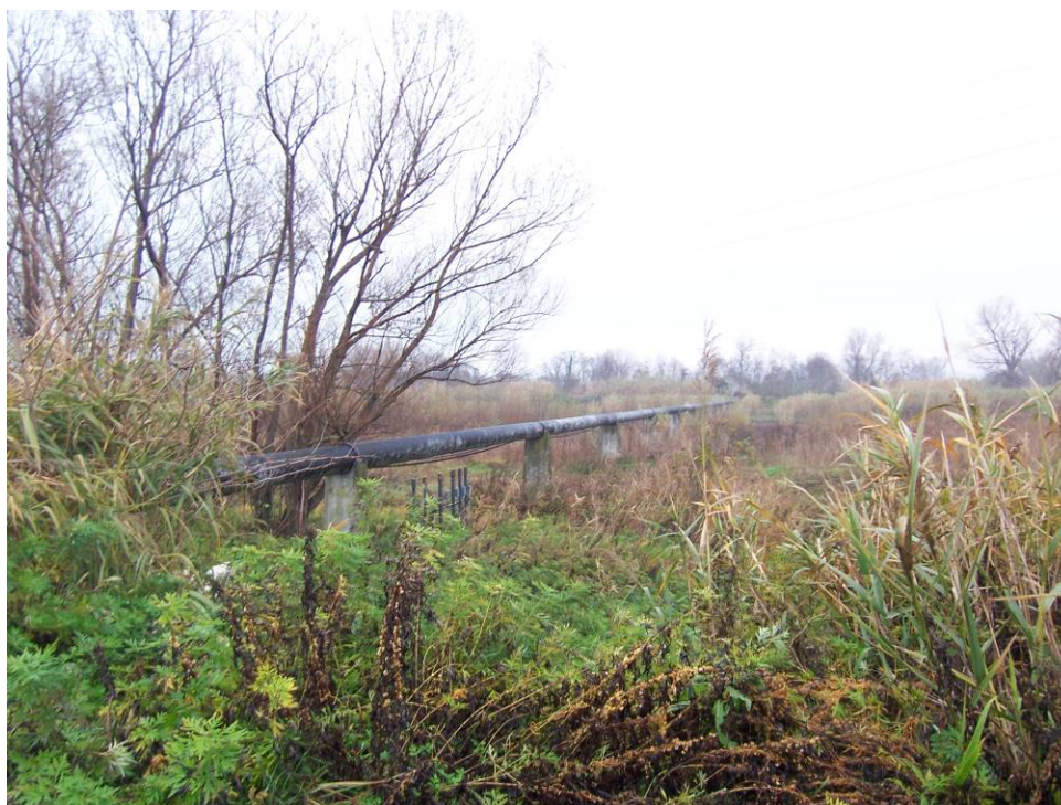
Foto 8 – Sponda sx fiume Esino nei pressi dell'attraversamento aereo dell'acquedotto
