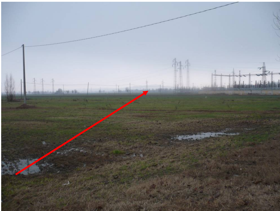
Foto 12 – Panoramica a valle attraversamento della SP 76
