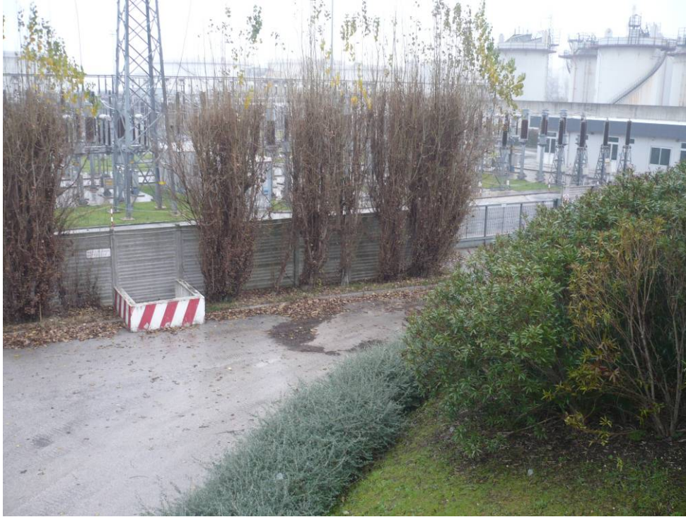
Foto 1 – Muro perimetrale della raffineria Api (Falconara)
