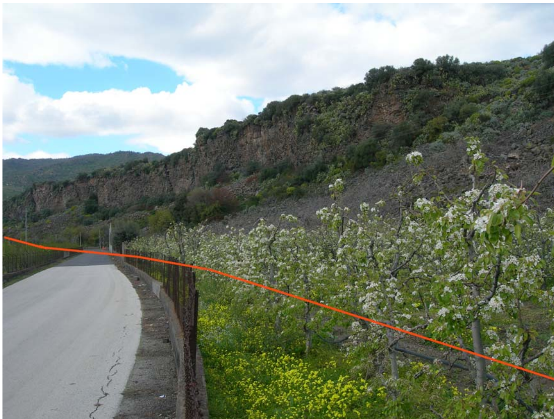
Foto 2.3/G: Panoramica della scarpata in corrispondenza del km 87,500.
