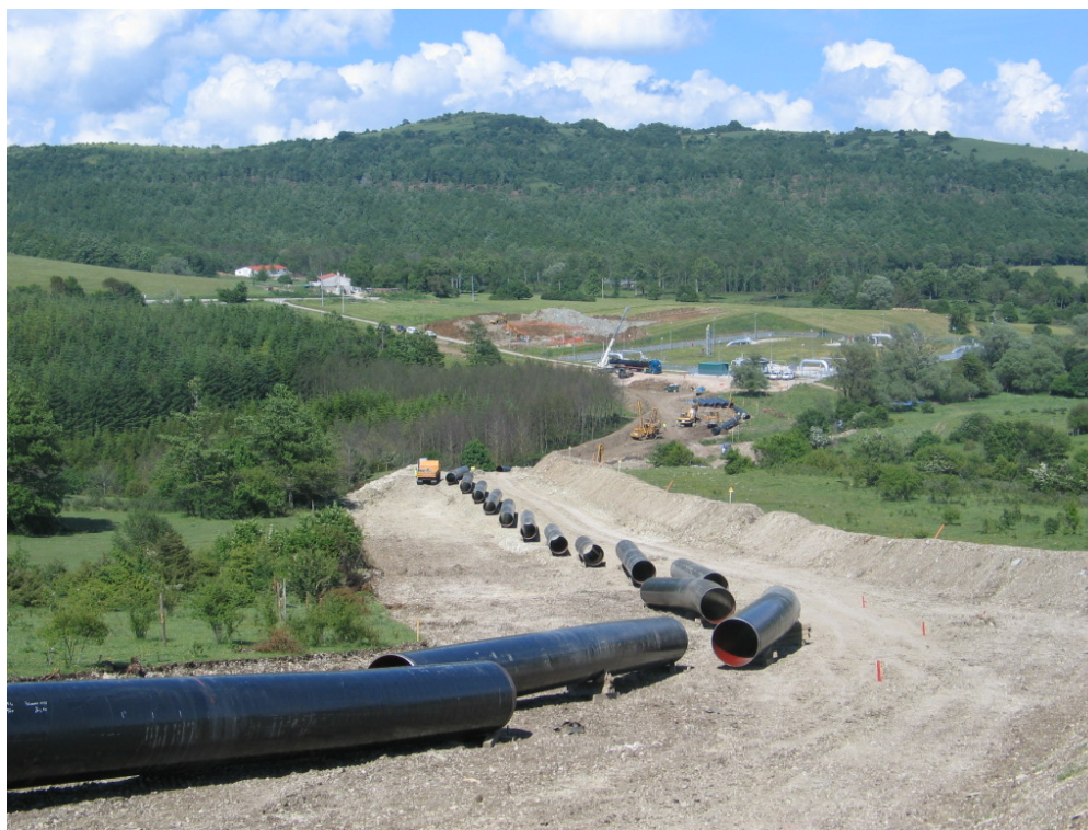
Foto 5.1/C: Sfilamento tubazioni
