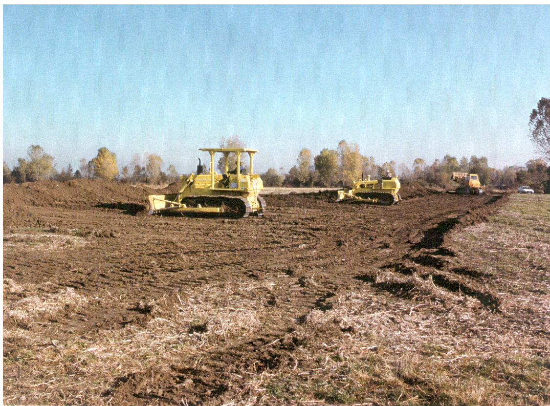
Foto 5.1/B: Apertura dell'area di passaggio
