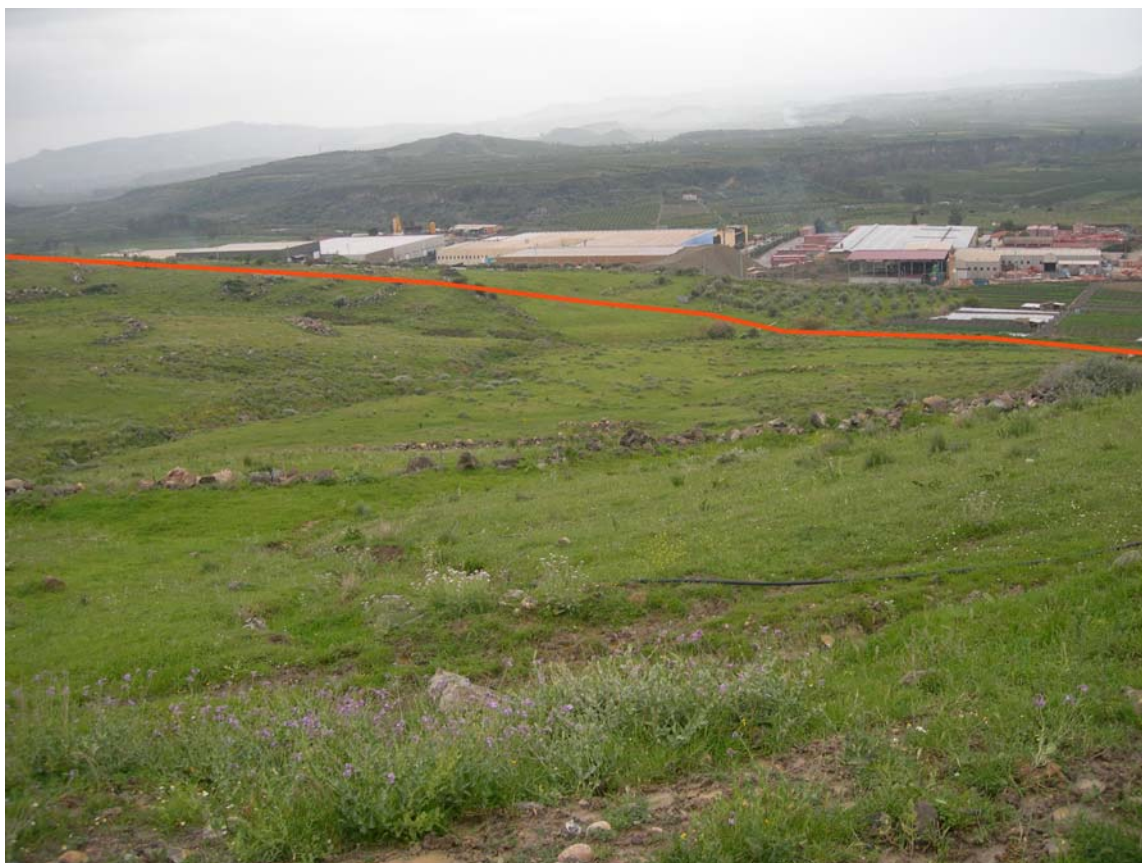
Foto 2.3/F: Panoramica del pendio in corrispondenza del km 73,250.
