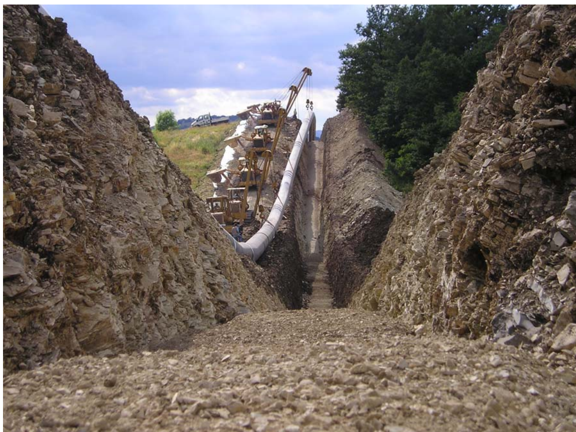
Foto 5.1/F: Posa della condotta
