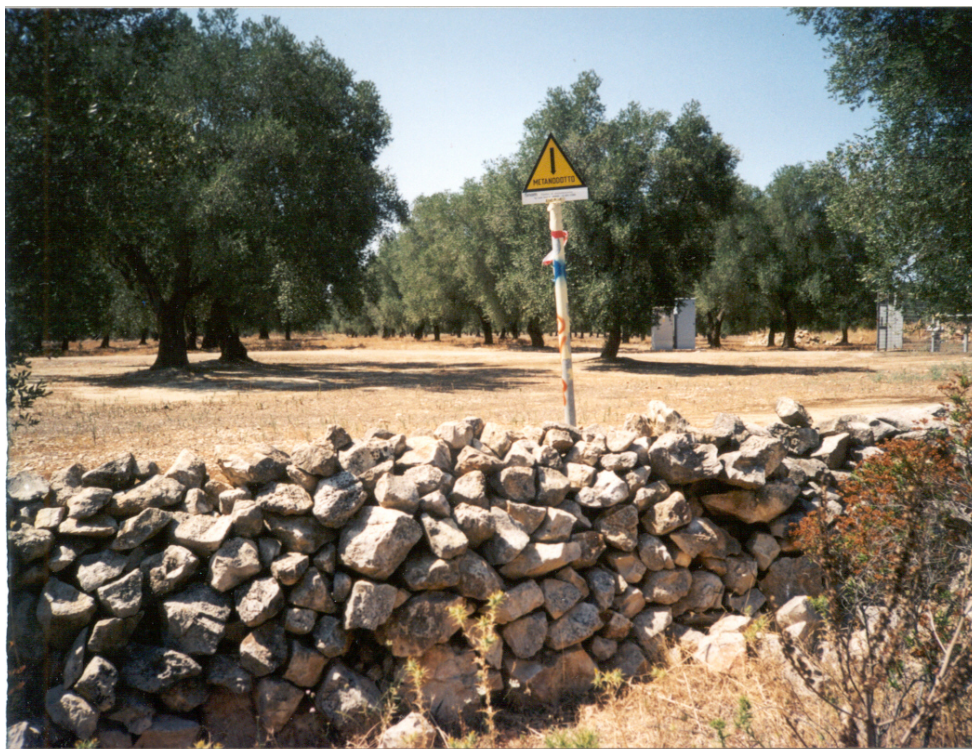
Foto 9/M: Ripristino di muri a secco.
