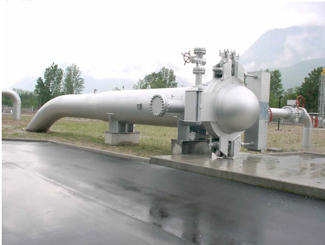
Foto 4.2/A: Punto di lancio e ricevimento pig
