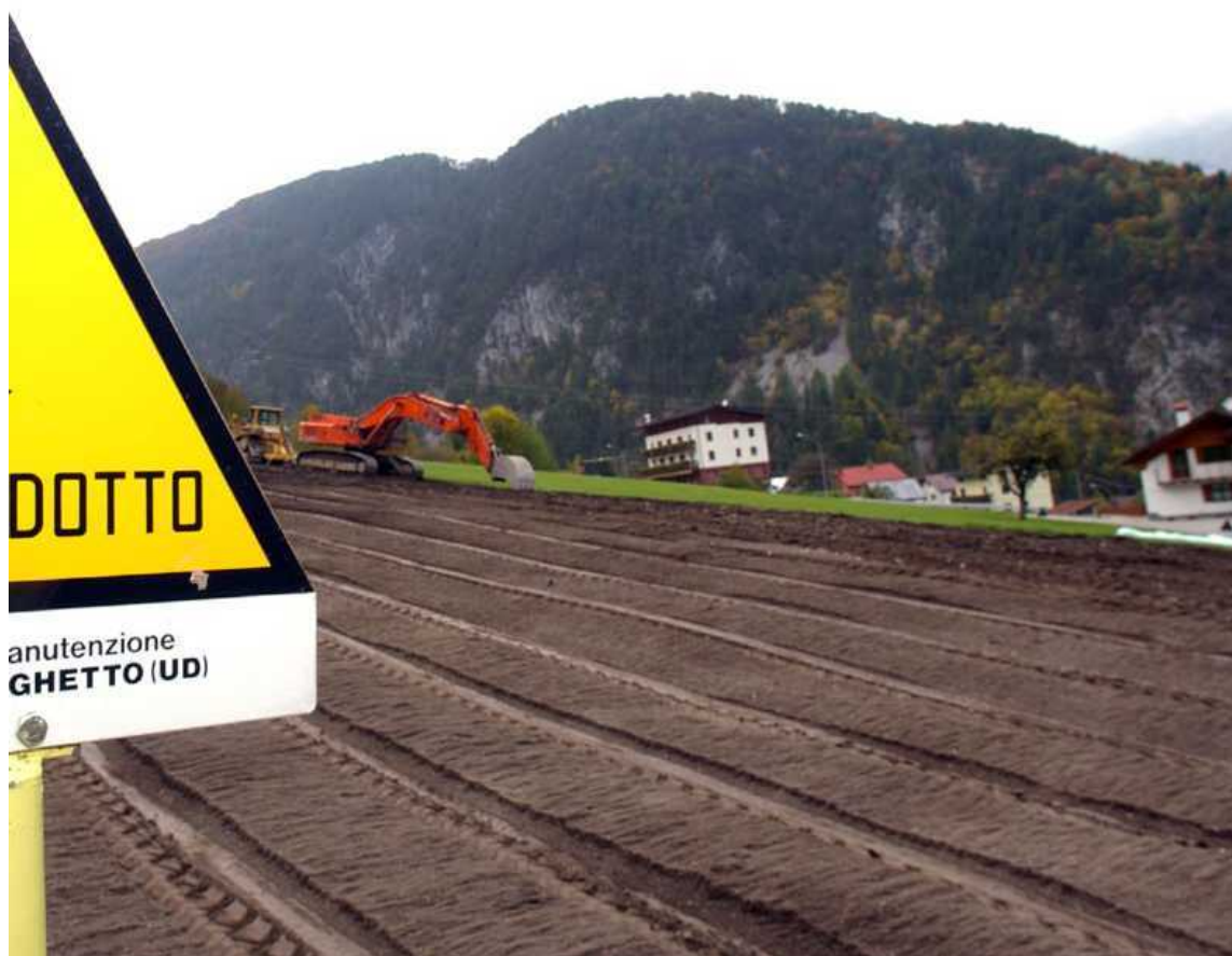
Foto 5.1/I: Ridistribuzione dello strato humico superficiale
