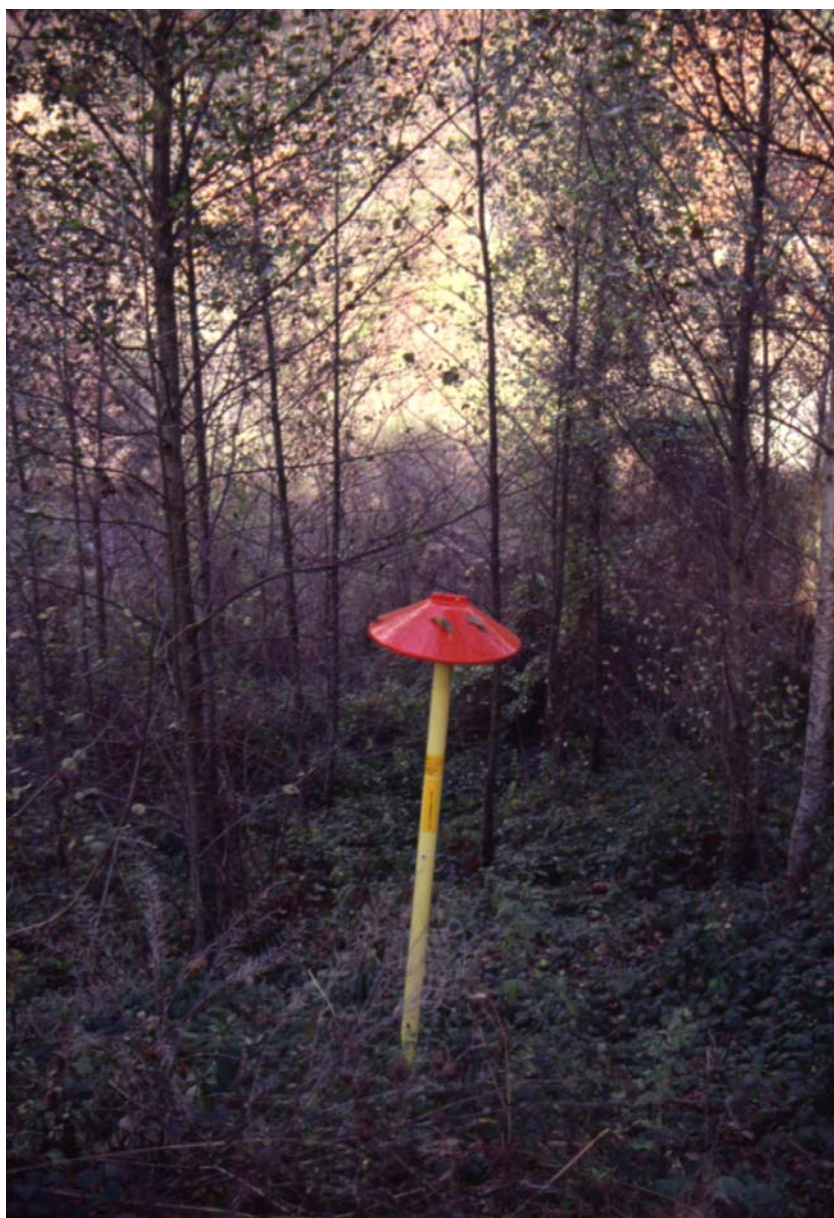
Foto 9/C Metanodotto realizzato nel 1980: rivegetazione (naturale non sono stati eseguiti ripristini) totale del metanodotto, le paline sono totalmente nascoste dalla vegetazione.
