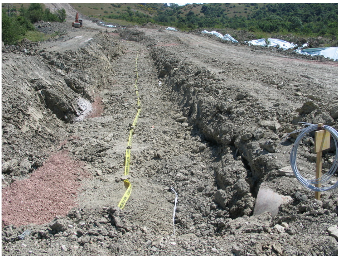
Foto 5.1/H: Rinterro della condotta
