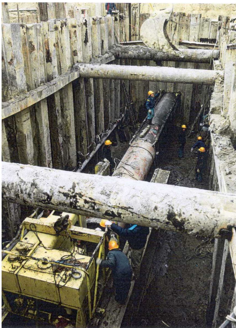
Foto 5.1/L: Trivellazione con spingitubo
