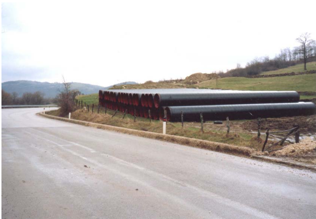
Foto 5.1/A: Piazzola di accatastamento tubazioni
