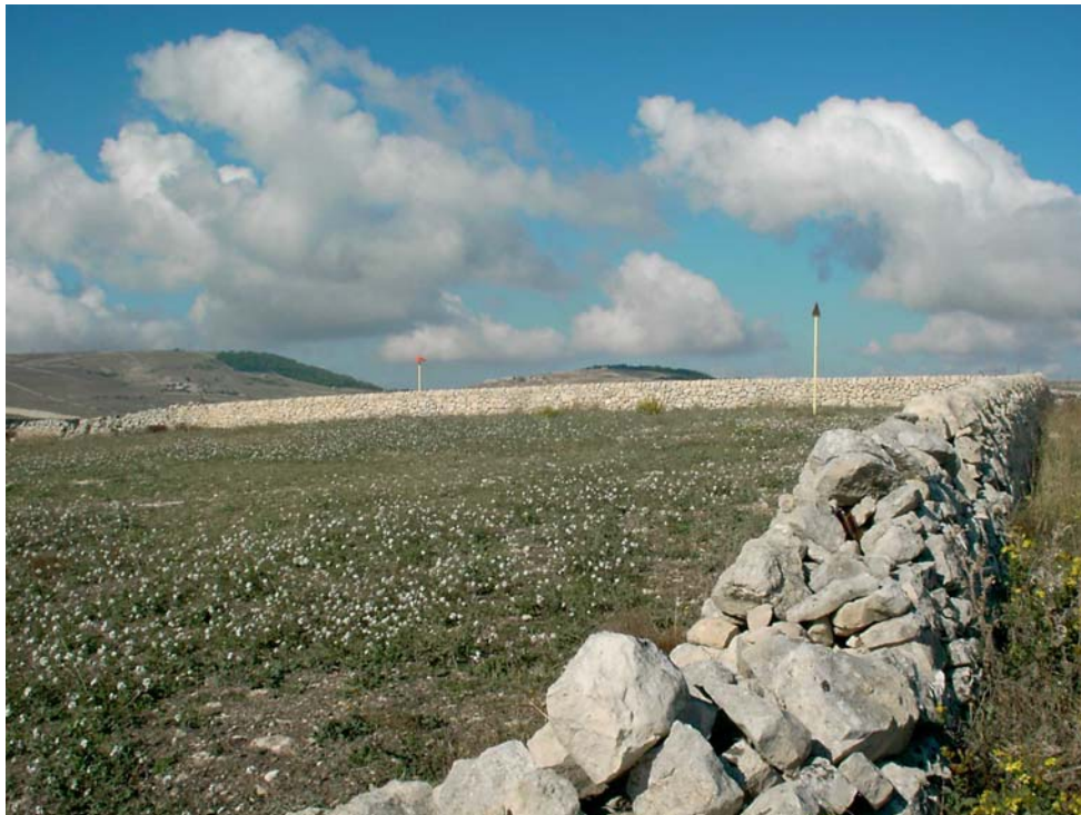
Foto 9/L: Ripristino di muri a secco.
