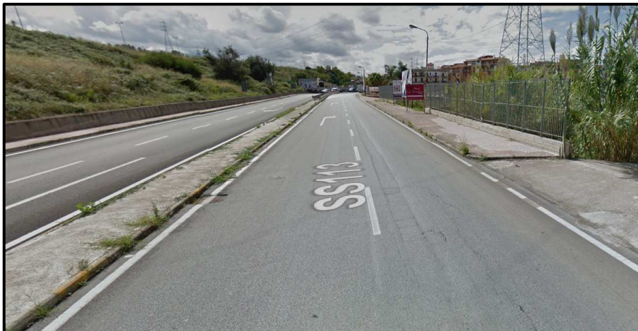
Figura 4.2.9b S.S. n.113 Via Statale - Tratto che attraversa l'abitato di Archi (1 di 2)
