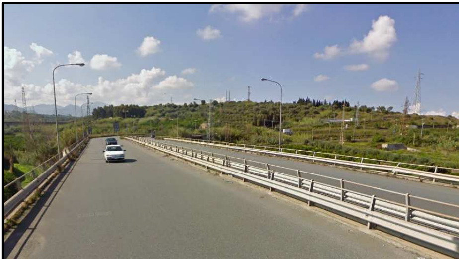
Figura 4.2.9d S.S. n.113 Tratto di più recente realizzazione
