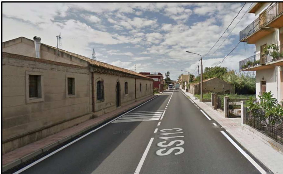
Figura 4.2.9c S.S. n.113 Via Statale - Tratto che attraversa l'abitato di Archi (2 di 2)
