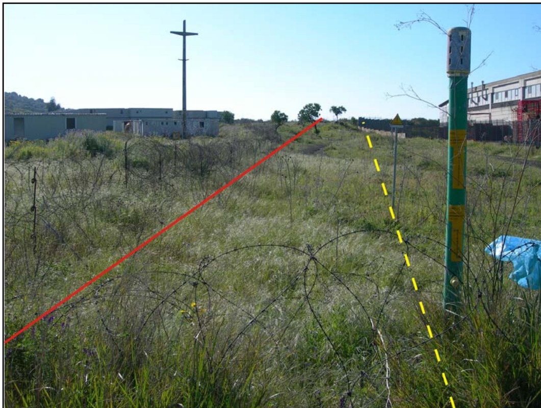
Foto 42: Tracciato della condotta a sud della SP n.44
