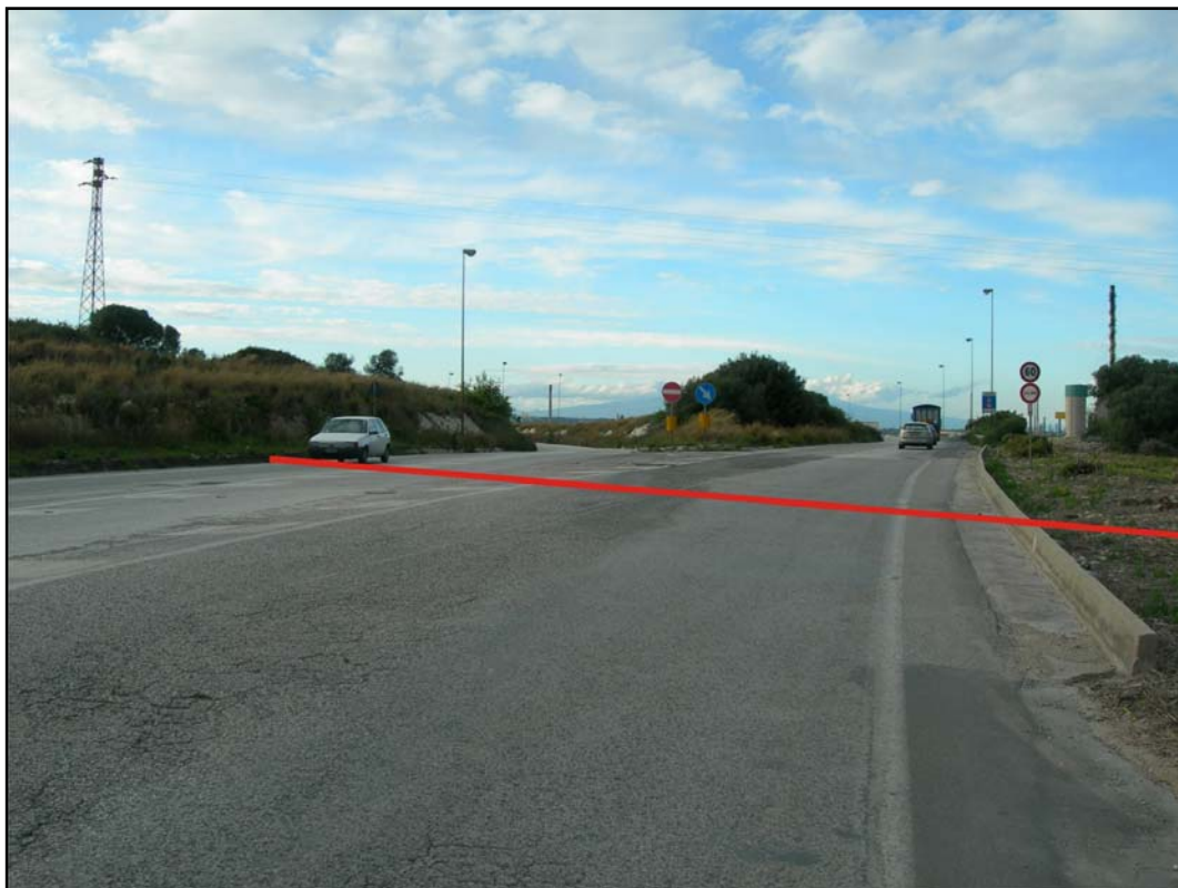
Foto 1: Attraversamento della Strada Provinciale Litoranea
