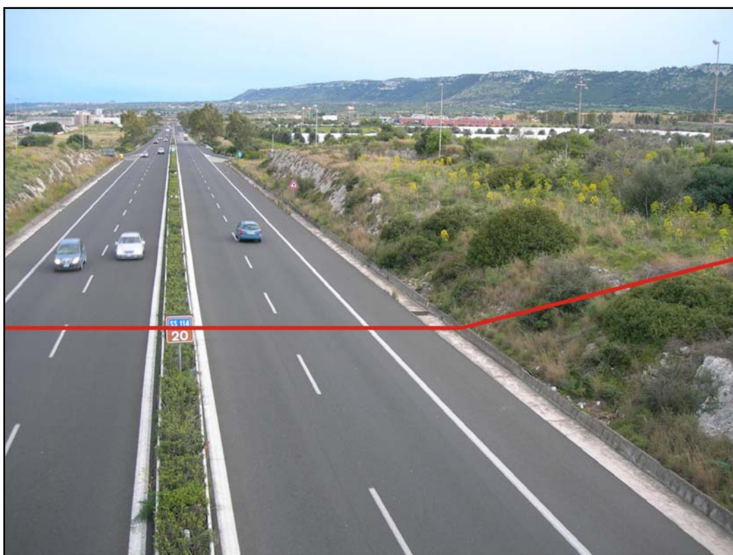
Foto 6: Attraversamento della SS n.114
