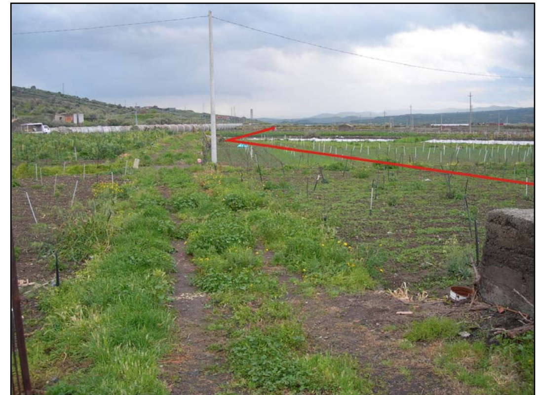
Foto 48: Tracciato della condotta in località Carribba
