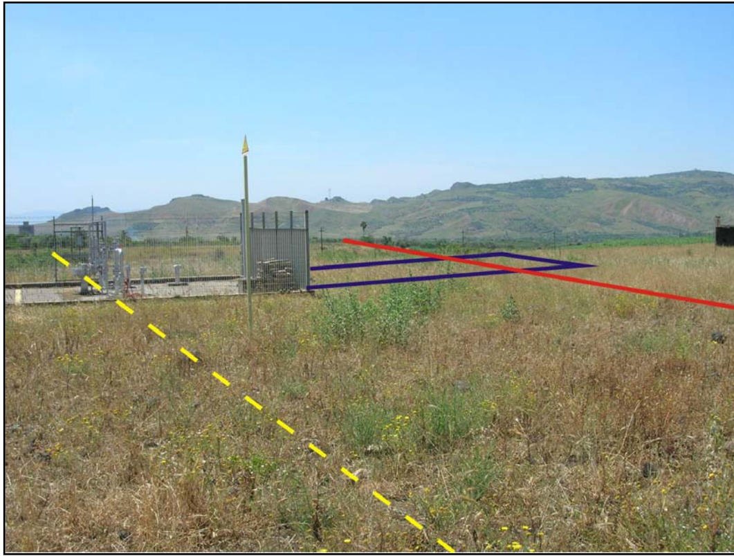
Foto A13: L'area del PIL n.13, in loc. Ponte la Bufala
