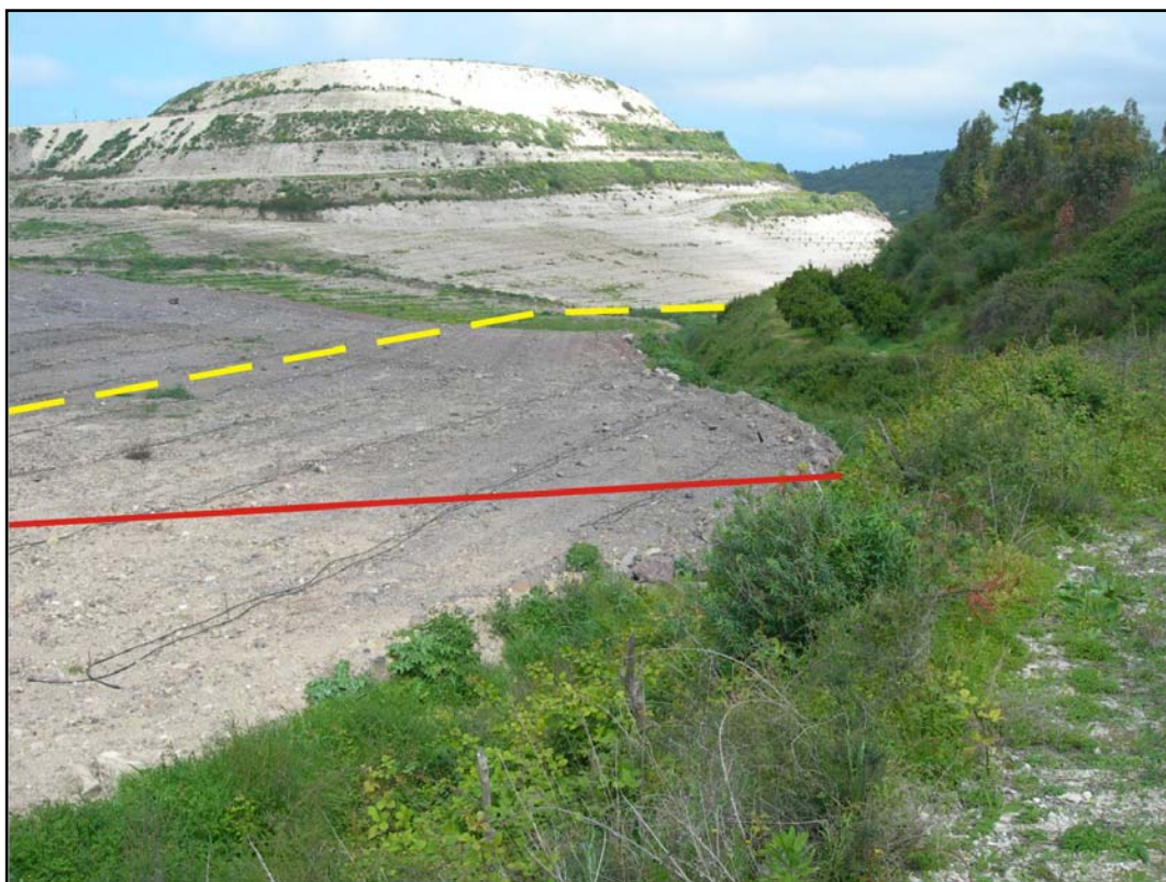
Foto 18: Imbocco settentrionale del microtunnel in località Crifesi
