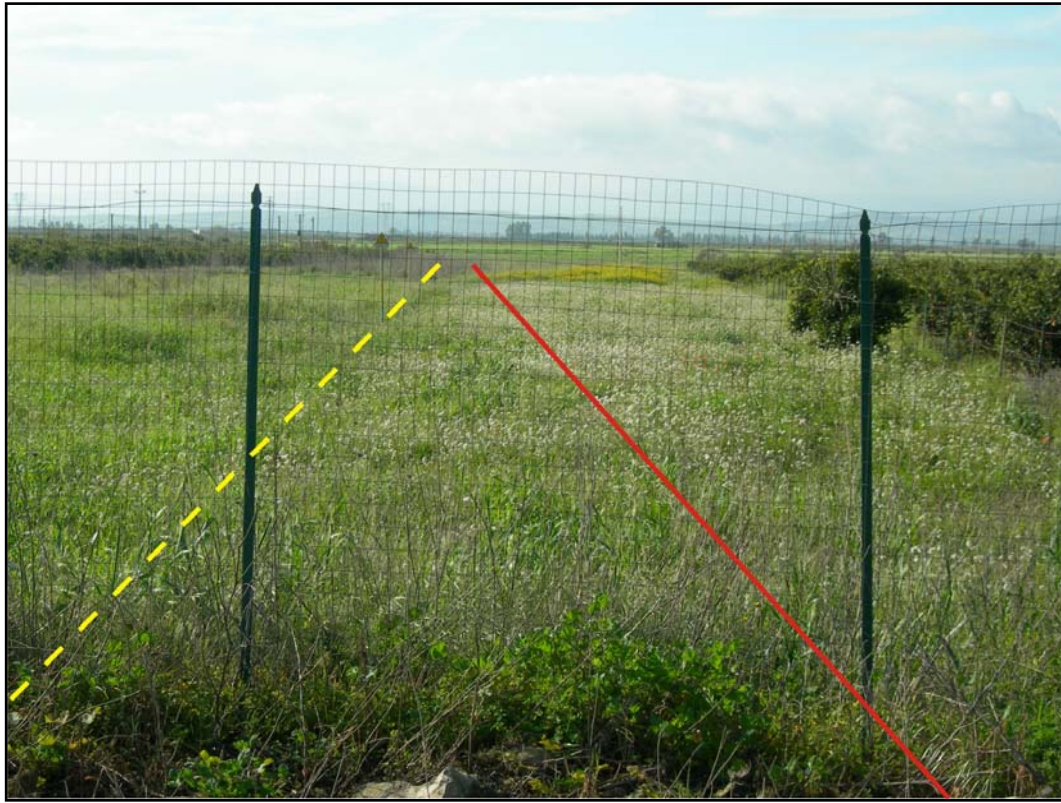
Foto 29: Tracciato della condotta a sud della SS n.192 della Valle del Dittaino
