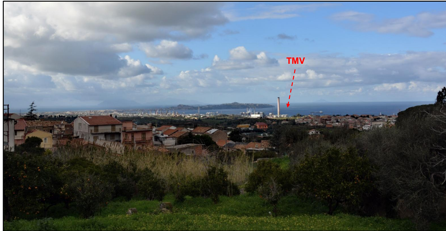
Figura 4.2.2.2i Ripresa Fotografica da PV7
