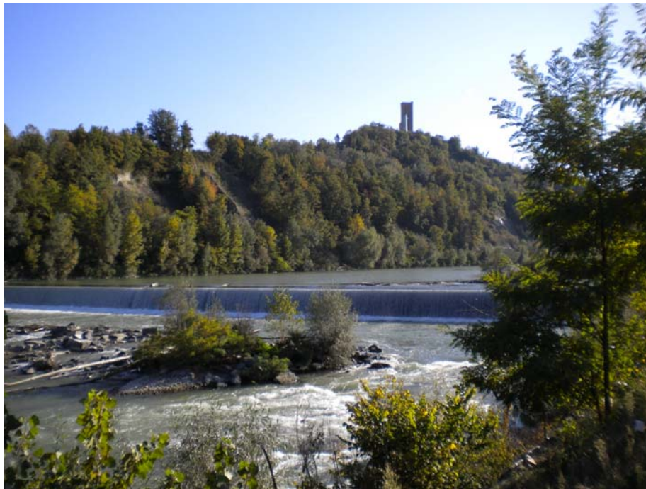
Fig. 3.1 Traversa esistente prima del crollo avvenuto nel novembre del 2010.
