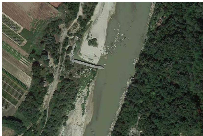
Fig.6.1 Foto aerea della zona di interesse. Si evidenzia la presenza della traversa in buona parte crollata. Il crollo dell'opera è avvenuto nel novembre 2010. (Fonte Google Earth, 2013)
