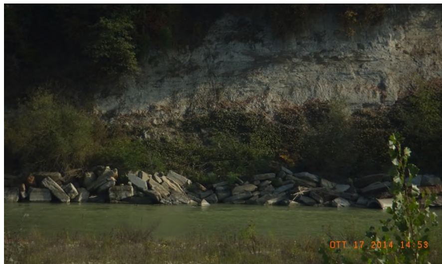
Figura 4.2 – Fotogramma di un tratto della scogliera a massi ciclopici compromessa.
