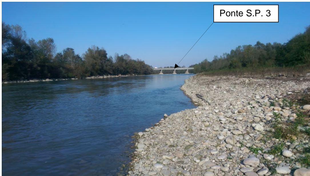
Figura 4.4 – Affioramento dei depositi attuali lungo la sponda in idrografica destra.
