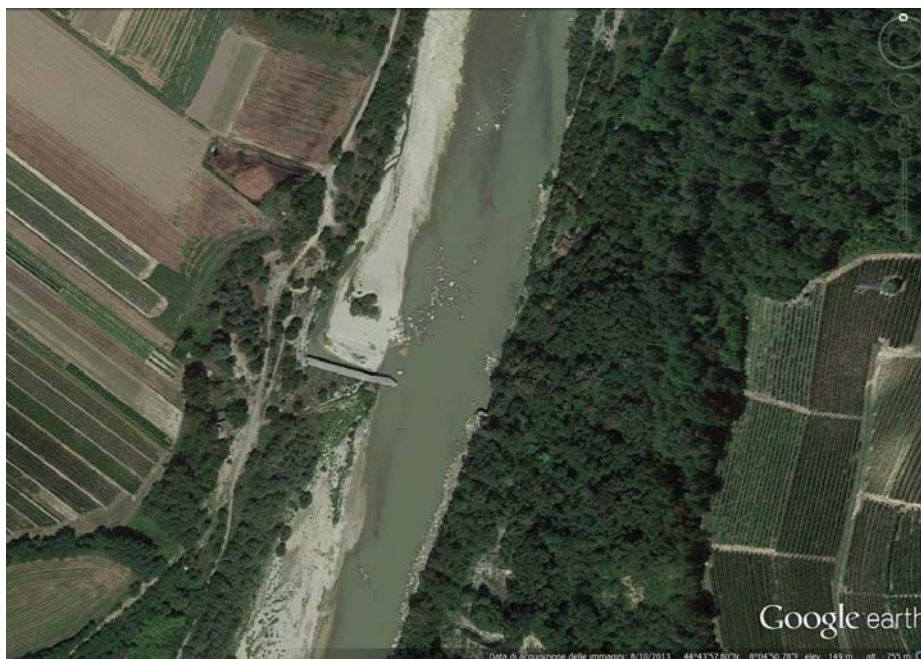
Fig. 1.3 Dettaglio della traversa esistente in evidente stato di dissesto a causa del crollo del novembre 2010. Fonte: Google Earth, 2013 (immagine non in scala).
