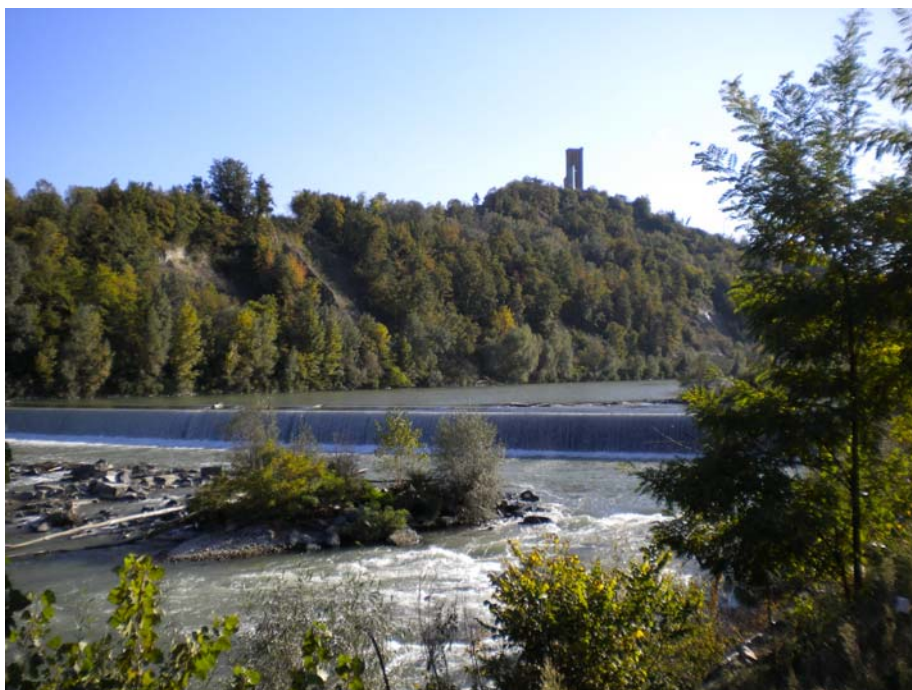
Fig. 2.1 Traversa esistente prima del crollo avvenuto nel novembre del 2010.
