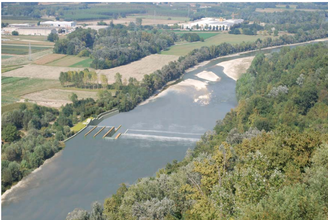
fotoinserimento 1: vista panoramica dell'impianto in progetto.
