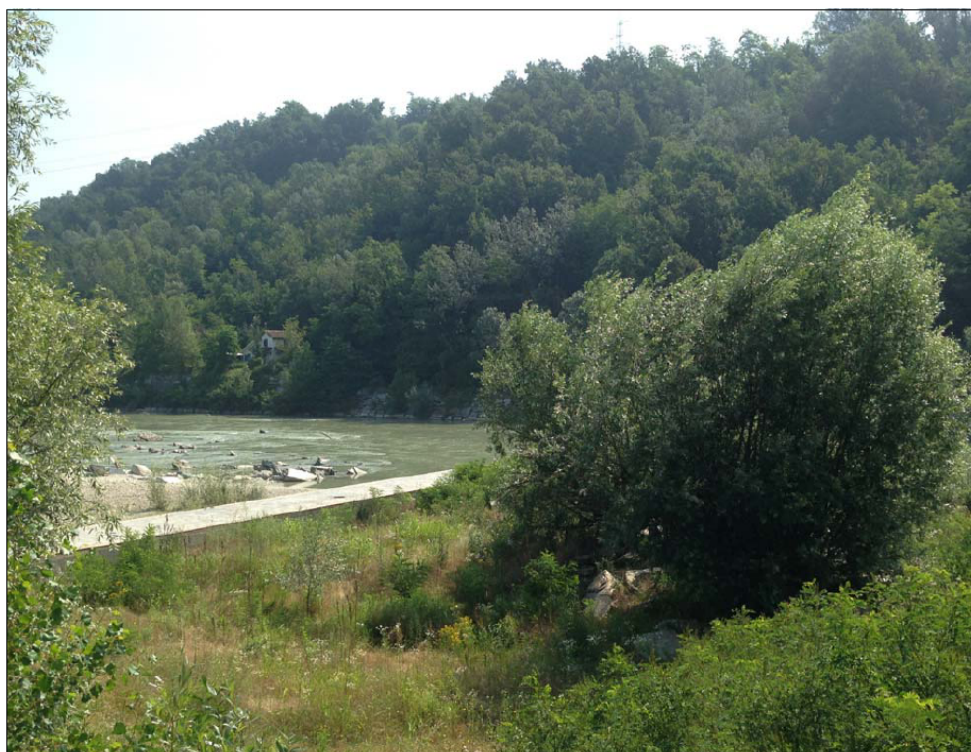
foto 8: vista da monte verso valle della traversa esistente.
