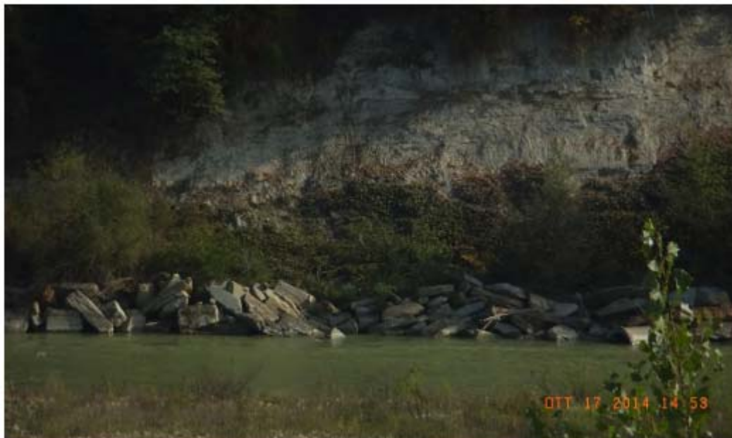
Fig. 5.2 Fotogramma di un tratto della scogliera a massi ciclopici compromessa.
