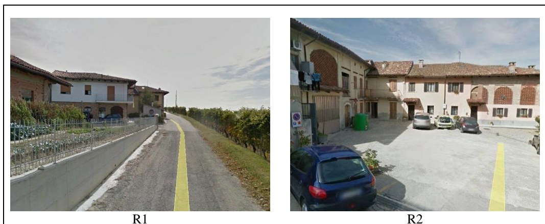
Figura 4-4 – Edifici ricettori nei pressi del sito (fonte: google earth)
