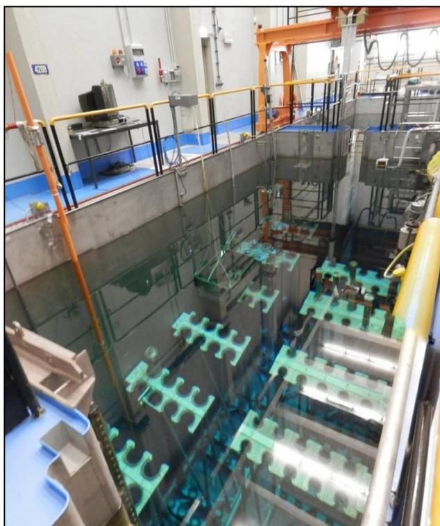
Figura 3-5: Edificio 81 – Vista d'insieme della piscina del combustibile esausto
