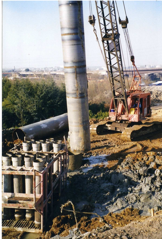
Lotto 22A - Svincolo GRA – Ponte sul Tevere – Posa in opera lamierini
