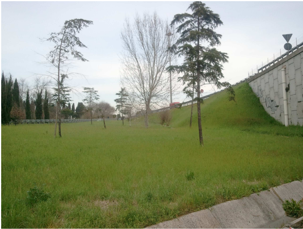
Area di svincolo – carreggiata esterna - Rampa Direzione Civitavecchia
