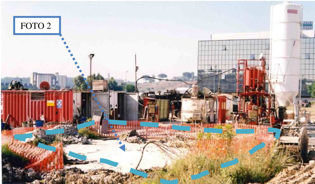
Lotto 23-1° Area di cantiere zona "Pescaccio"
