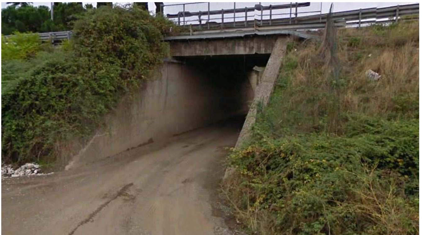
Sottovia Scatolare km 46+800
