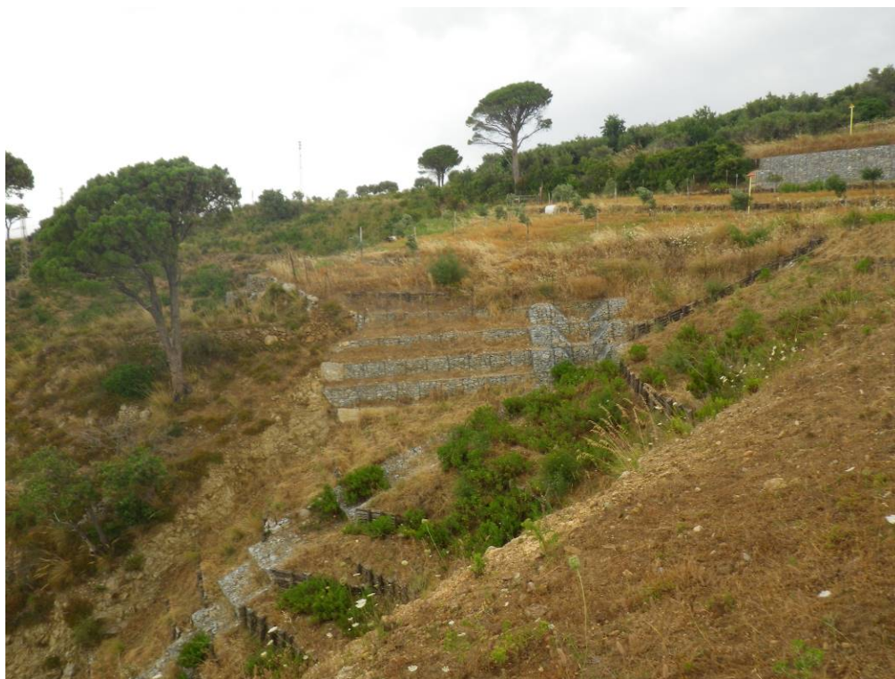
Foto 3.15 - tracciato del metanodotto (2014).
