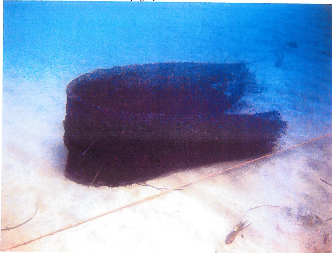
Fig. 1- Stuoia di copertura dei materassi della sub area 1 strappata e posizionata sul fondo adiacente.
