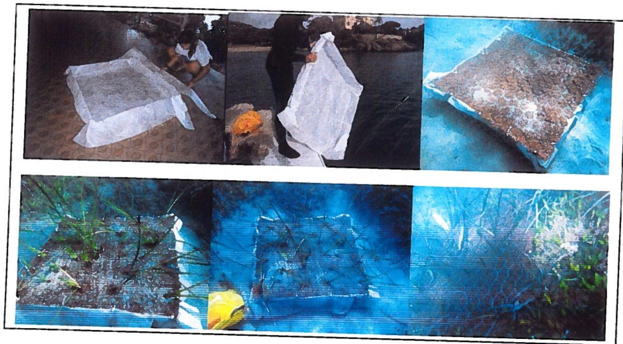
Fig. 1 - Rivestimento materasso "Reno" in rete metallica con geotessuto. (1), Materasso Reno pronto alla messa in mare (2), Materasso Reno collocato sul fondo, riempito di sabbia e coperto da geostuoia. (3), Talee di Posidonia oceanica fissate al coperchio del materasso (4), Talee in fase di crescita. (5), Mac Mat R fissato su "matte" morta di Posidonia oceanica con talee impiantate (6).
