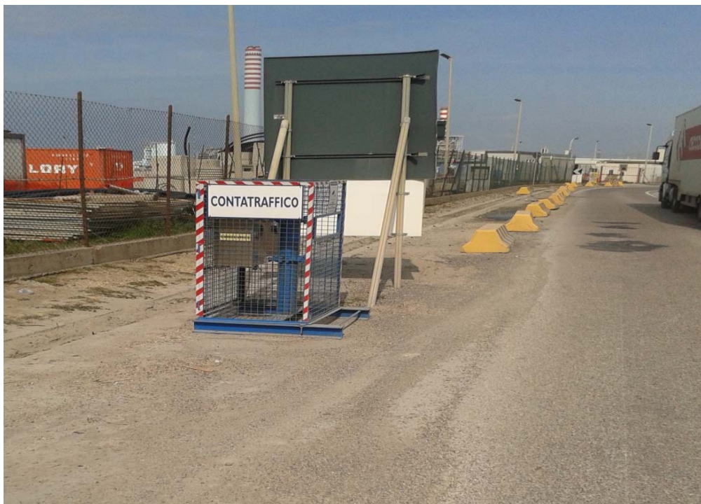
Misuratore di traffico veicolare, installazione presso Strada Litoranea Porto
