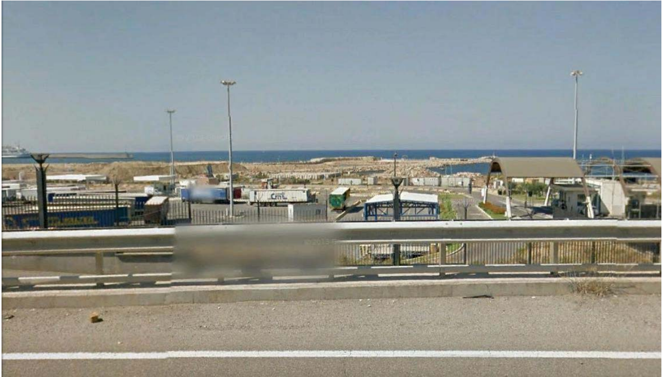
Immagini dalla S.S. Aurelia, direzione ovest, sullo sfondo l' area di cantiere.
