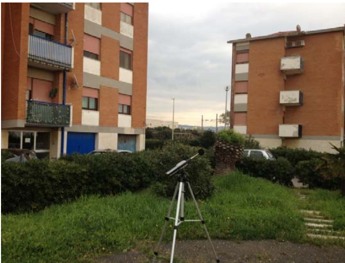
Fonometro collocato nella stessa posizione della campagna estiva BI.LAB.2013 a circa 10 m di distanza dall’edificio lato nord
