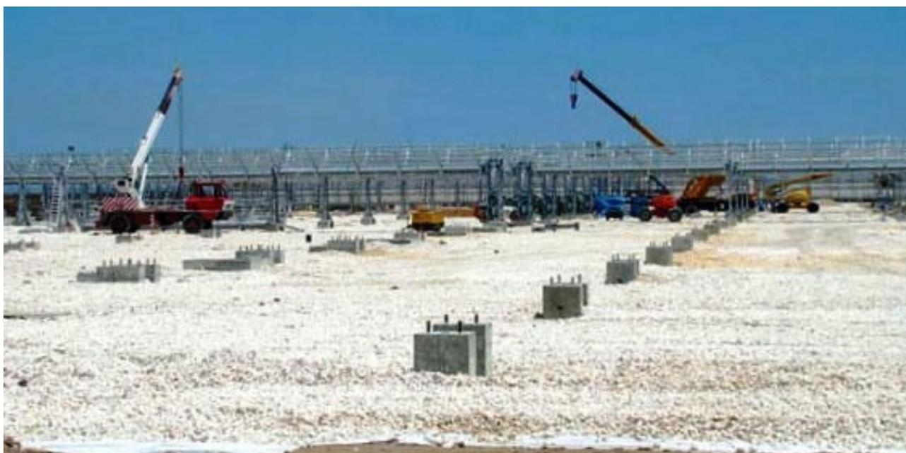
Nella figura 1 si possono vedere i plinti realizzati per sostenere gli specchi parabolici della Centrale termodinamica “Archimede”, il prototipo realizzato in Sicilia. Si tratta di un impianto di soli 5 MW di potenza. Considerate le potenze in gioco e la ventosità del sito, l’impatto che le colate di cemento potranno creare nella pianura del Basso Campidano va considerato perlomeno decuplicato.
