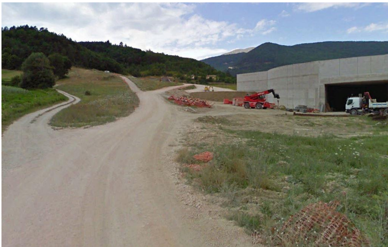
Figura 4 – Immagine dell'area della strada di cantiere Ante Operam.
