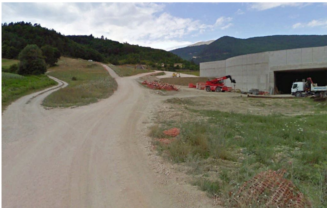
Figura 6 – Immagine dell'area della strada di cantiere Ante Operam .
