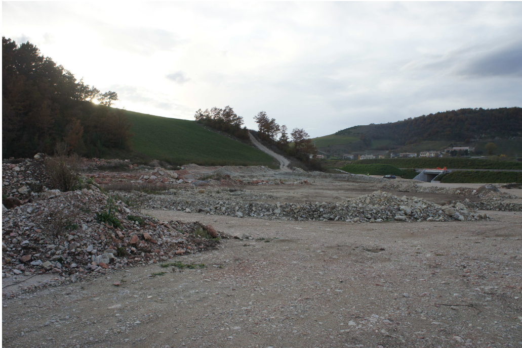
Figura 6.b - Immagine dell'area in fase di cantiere
