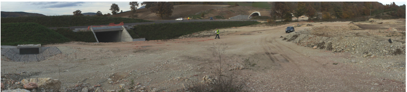
Figura 6.a - Immagine dell'area in fase di cantiere
