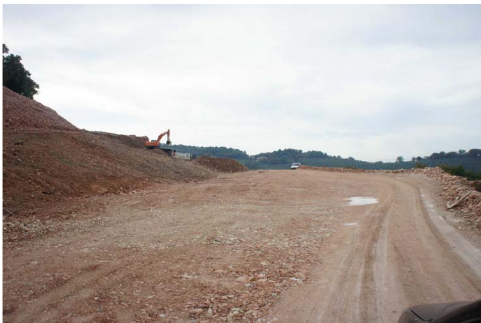
Figura 7.b - Immagine dell'area in fase di cantiere
