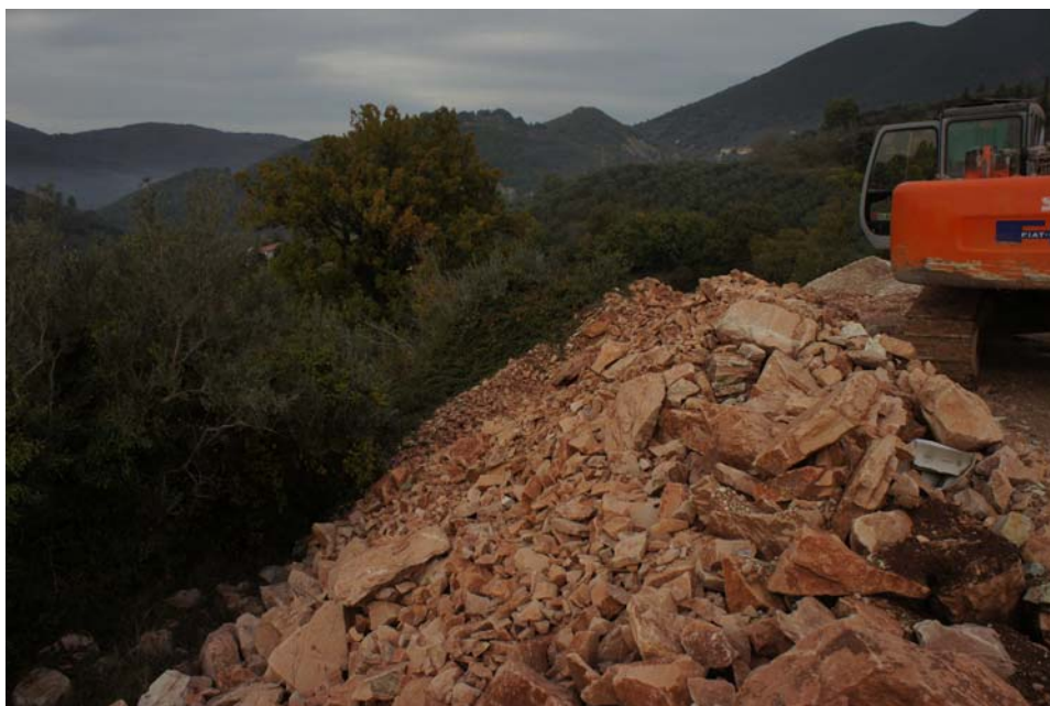
Figura 7.d - Immagine dell'area in fase di cantiere
