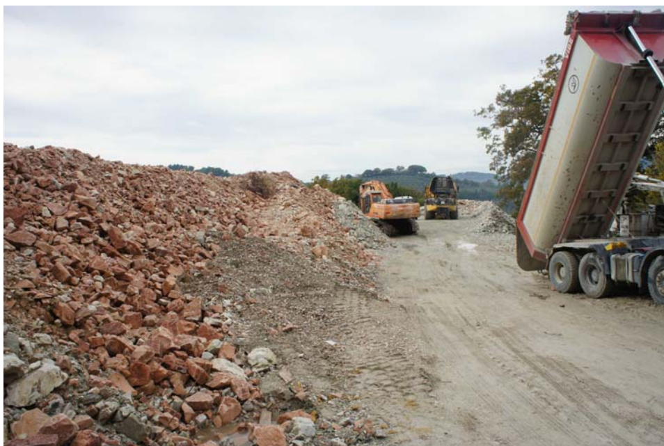
Figura 7.a - Immagine dell'area in fase di cantiere
