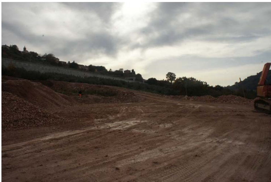
Figura 7.c - Immagine dell'area in fase di cantiere
