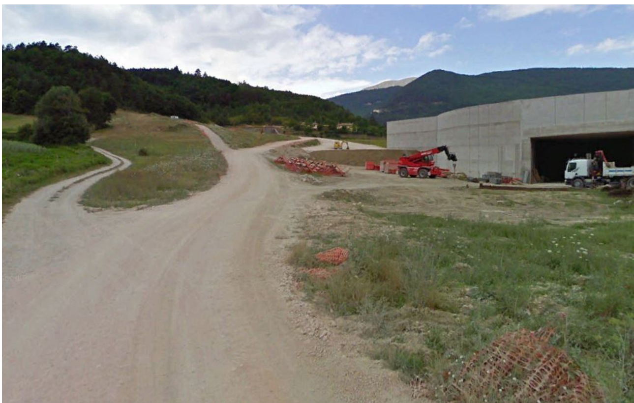
Figura 6 – Immagine dell’area di cantiere Ante Operam .
