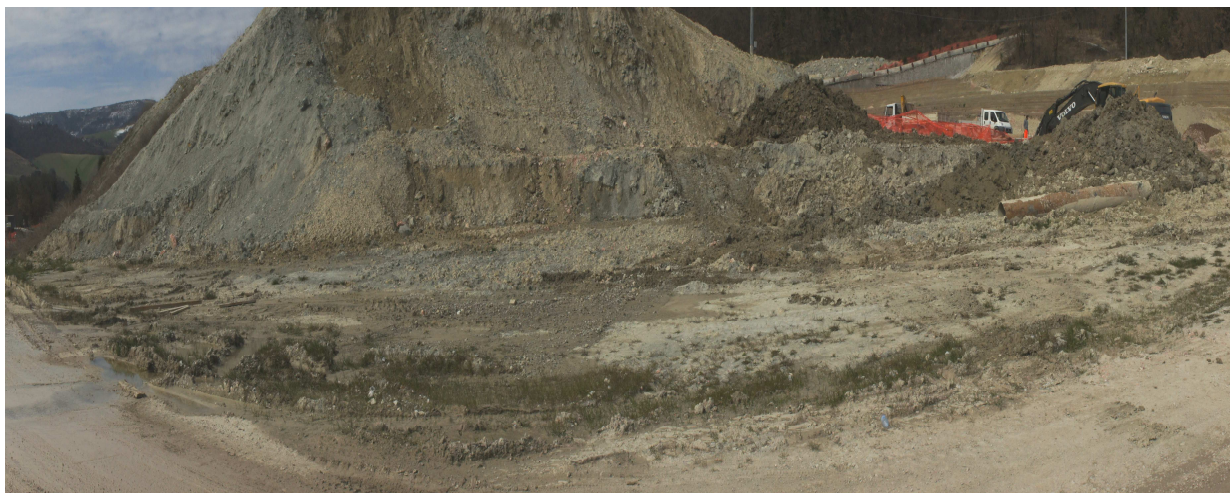
FIGURA 6.C - IMMAGINE DELL'AREA IN FASE DI CANTIERE
