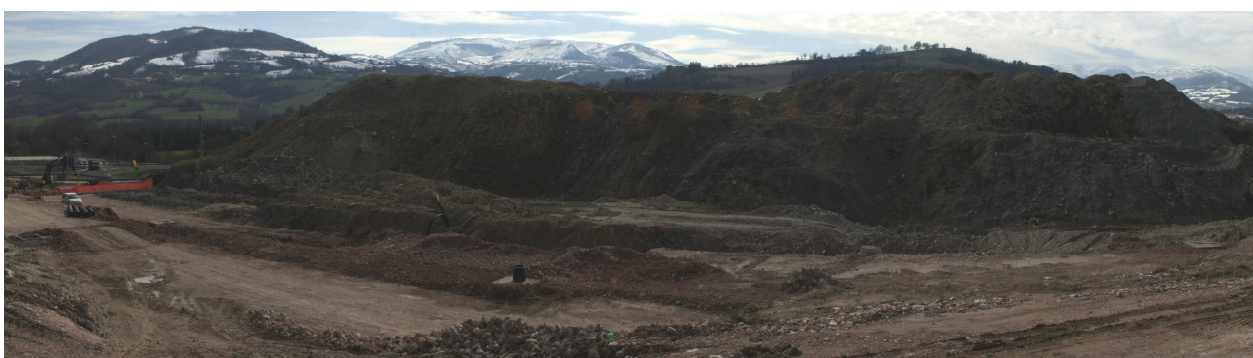
FIGURA 6.D - IMMAGINE DELL'AREA IN FASE DI CANTIERE
