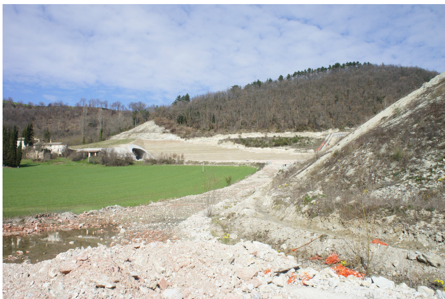
FIGURA 6.A - IMMAGINE DELL'AREA IN FASE DI CANTIERE
