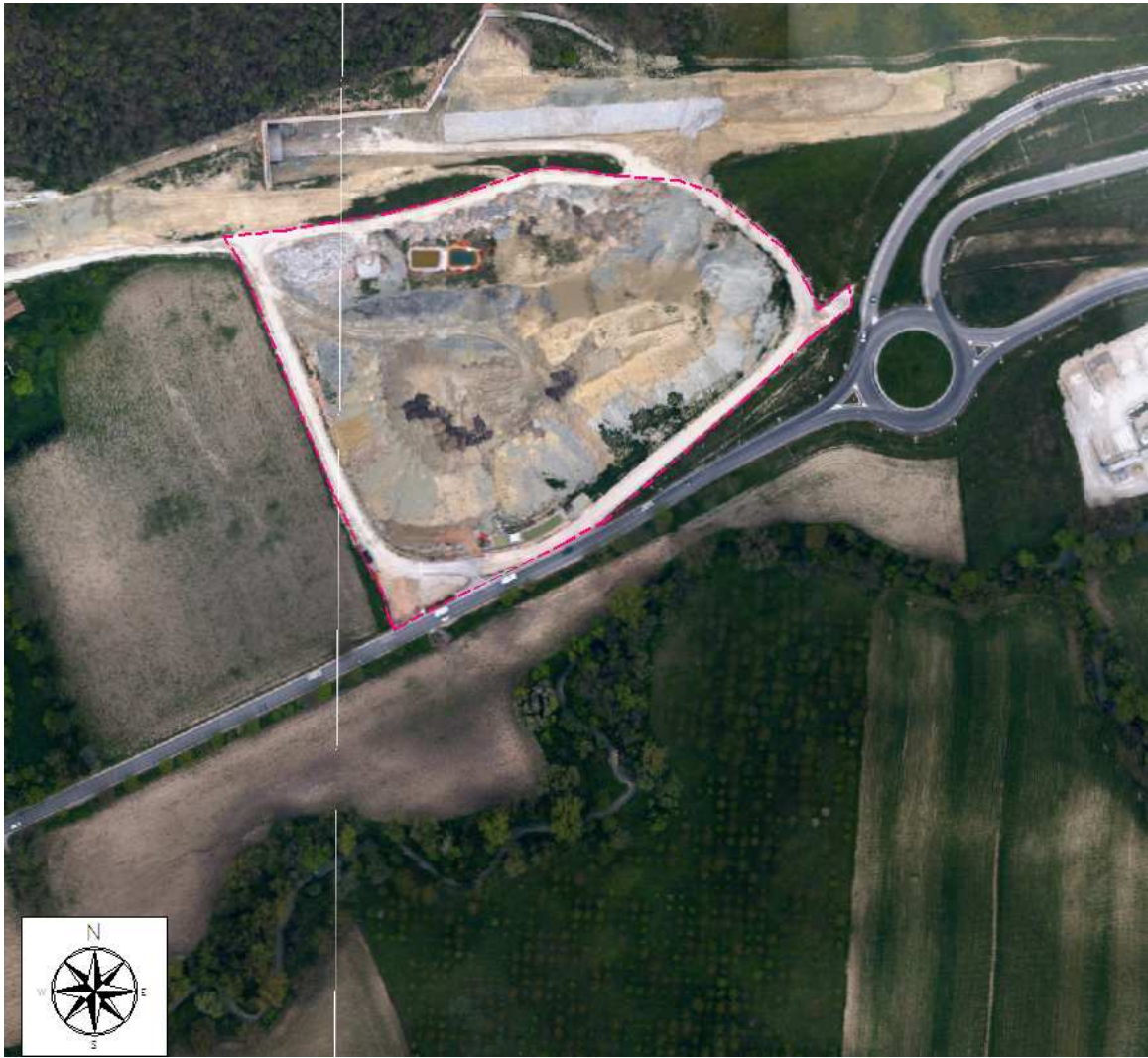
FIGURA 2 - ORTOFOTO D'INQUADRAMENTO DELL'AREA "ST15" STATO ATTUALE (MAGGIO 2013).
