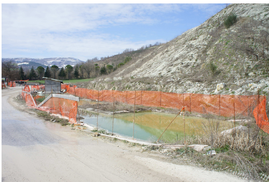
FIGURA 6.B - IMMAGINE DELL'AREA IN FASE DI CANTIERE
