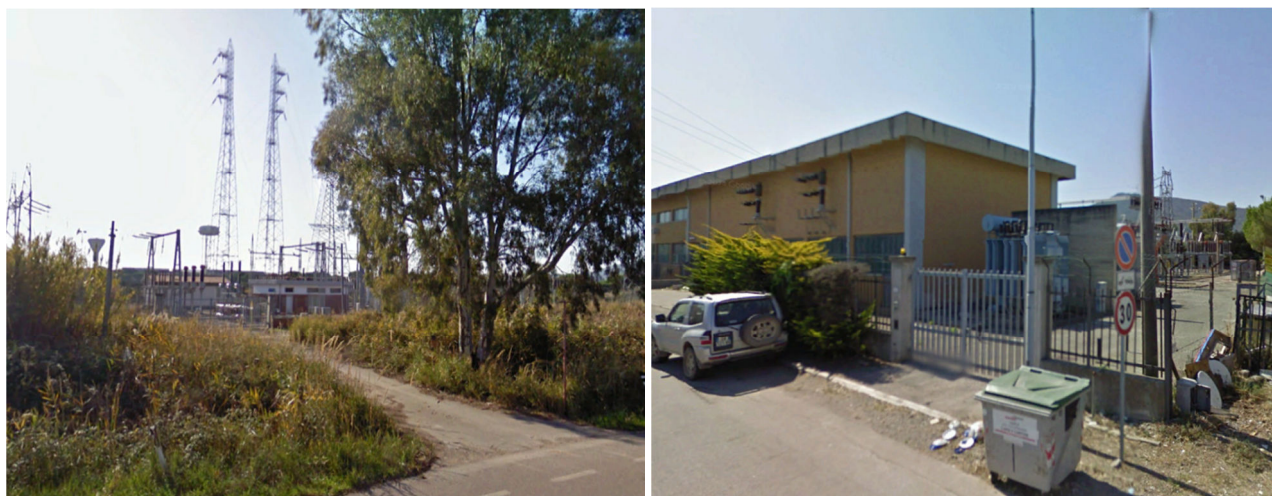
Figura 2.3: La SE di arrivo dei cavidotti di Piombino (sx) e CP Portoferraio (dx)
