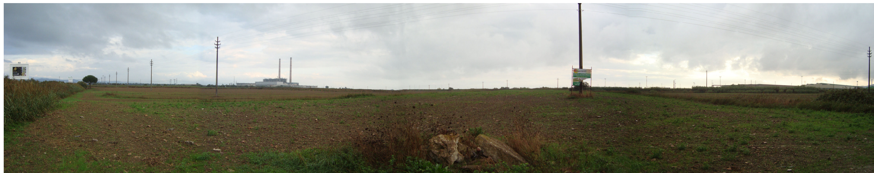
Foto 18: Vista dalla SP40 verso la Centrale Termica di Piombino (a sinistra) e l'area industriale di Piombino (a destra).
