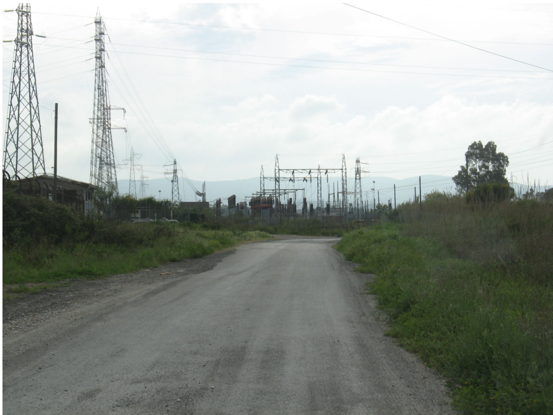
Foto 15: L'arrivo della strada sterrata interessata dal cavo interrato presso la Stazione Elettrica di Colmata.
