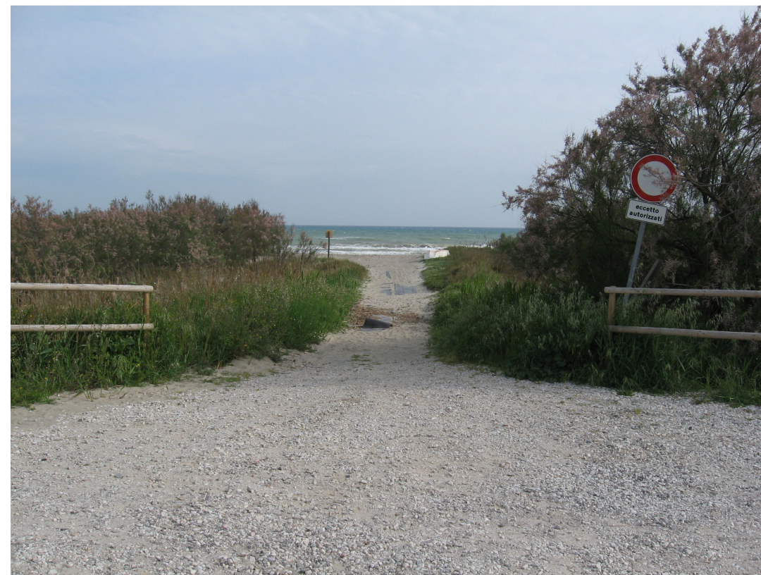
Foto 2: Il piccolo varco esistente sul cordone dunale, nel quale sarà posato il cavo interrato.
