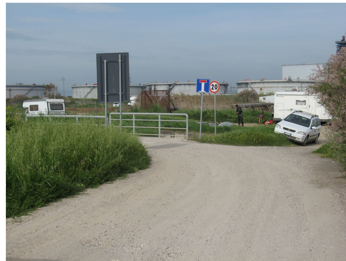
Foto 7: Ponte carrabile sul Fosso Tombola, in prossimità della Foce del Fiume Cornia.
