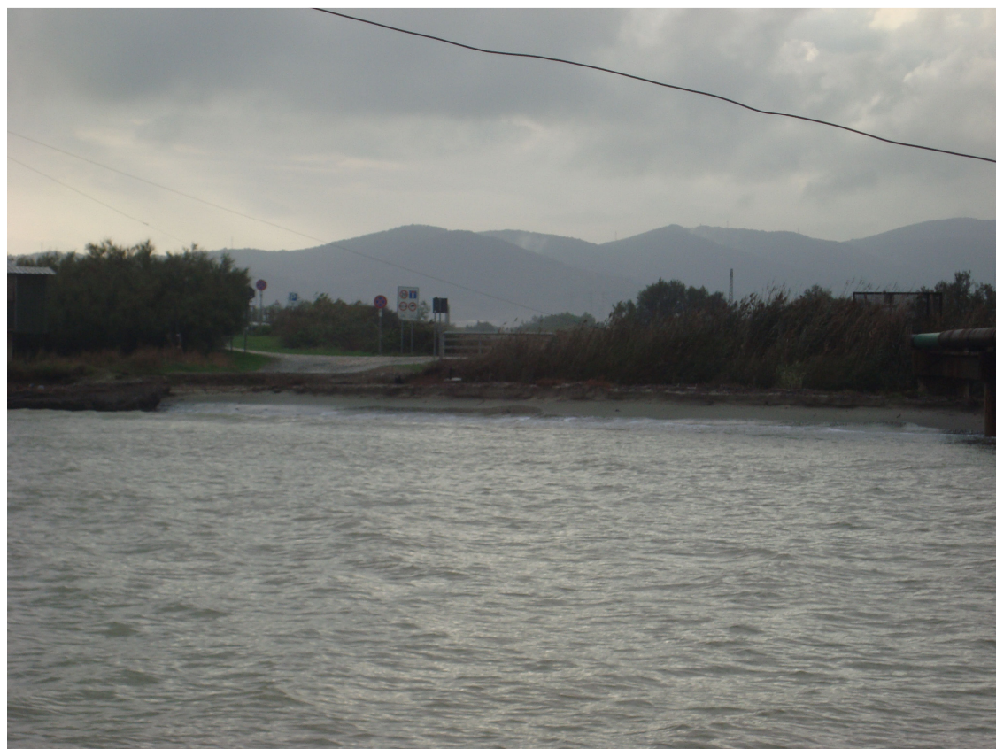
Foto 6: Ponte carrabile sul Fosso Tombola, vista dalla sponda sinistra del Fiume Cornia
