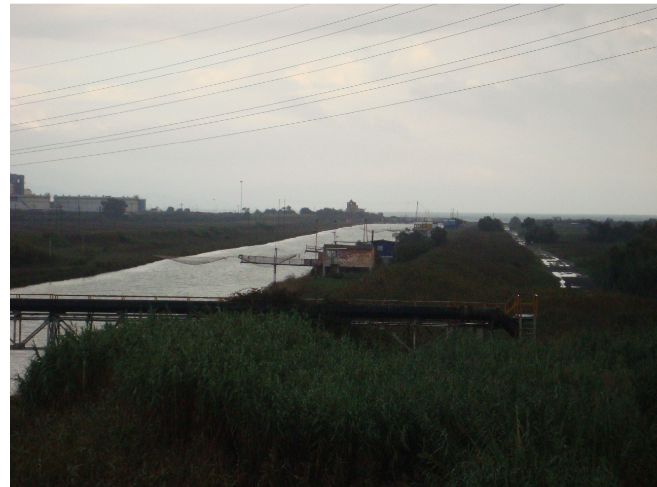
Foto 12: Fiume Cornia. A destra la strada sterrata interessata dall'intervento di posa del cavidotto.
