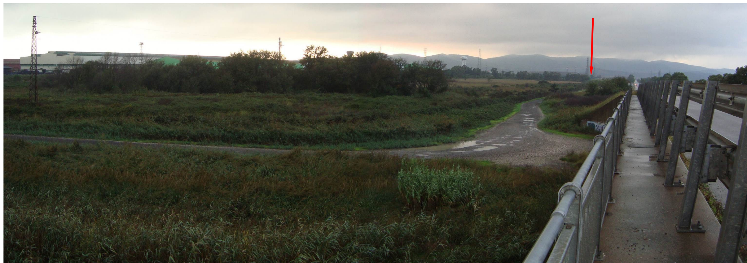
Foto 10: La strada sterrata che costeggia il SIN. Vista dal ponte sul fiume Cornia lungo la SP40 verso la CP Colmata (freccia rossa). Sulla sinistra della foto è visibile l'area industriale.
