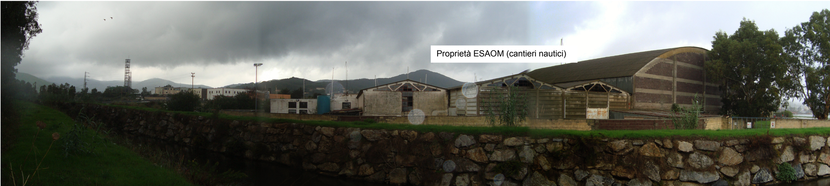
Foto 16: Portoferraio, vista dall'argine artificiale destro del Fosso della Madonnina. Il cavidotto terrestre sarà collocato ad una distanza di 4m dall'argine ed andrà ad interessare la proprietà ESAOM (Cantieri Nautici).
