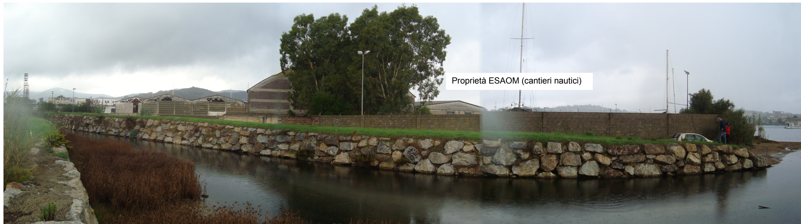
Foto 15: Portoferraio, vista della Foce del Fosso della Madonnina dall'argine artificiale destro in massi ciclopici. Il cavidotto terrestre sarà collocato ad una distanza di 4m dall'argine ed andrà ad interessare la proprietà ESAOM (Cantieri Nautici).
