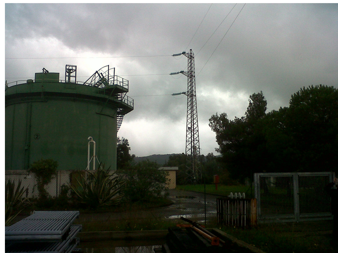
Foto 6: Vista dell'area posta ad est, adiacente la CP Portoferraio. Il tracciato del cavidotto si svilupperà in posizione retrostante i serbatoi e lungo il prato prospiciente il traliccio.
