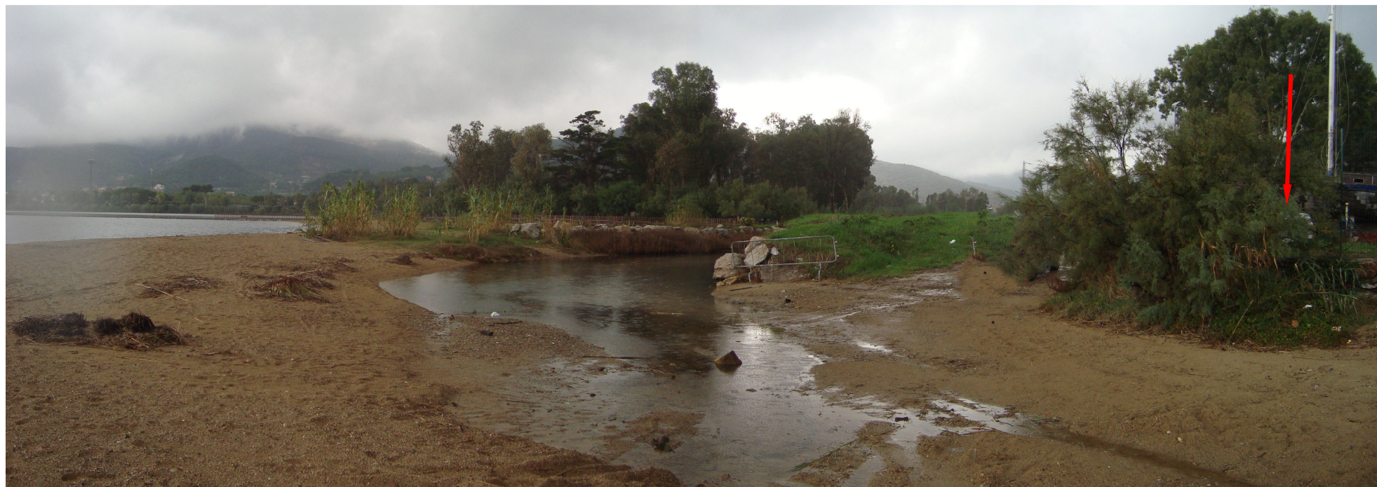
Foto 14: Portoferraio, vista dalla spiaggia della Foce del Fosso della Madonnina e del punto di giunzione fra cavo sottomarino e cavo interrato (interno al Cantiere Edilnautica – vedi freccia rossa). Sullo sfondo le Saline di San Giovanni.
