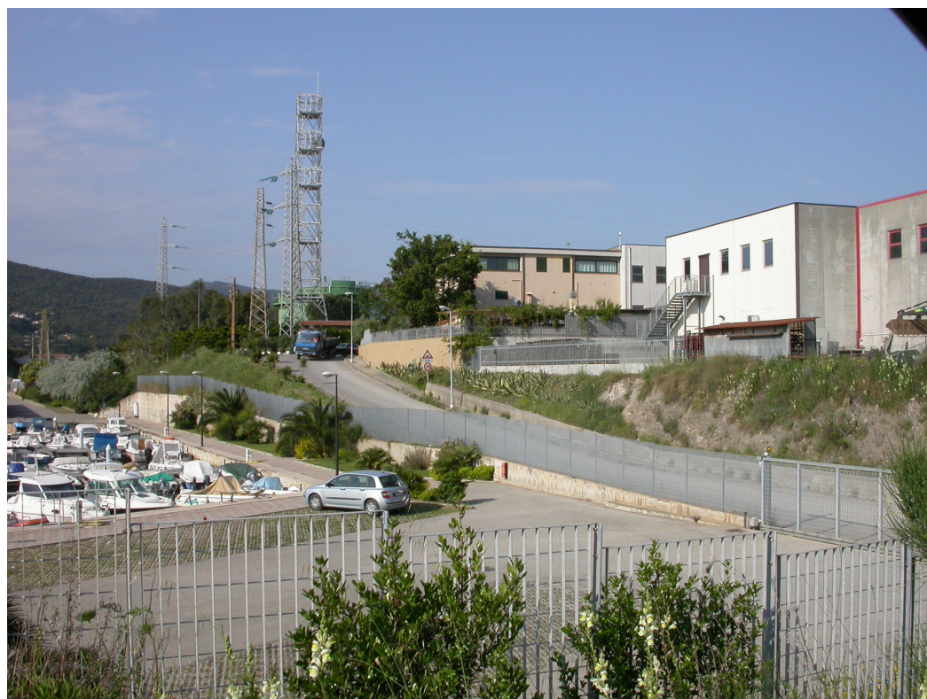
Foto 9: Portoferraio, margine della zona artigianale, con la strada asfaltata (via della Ferriera) interessata dal passaggio del cavo interrato.
