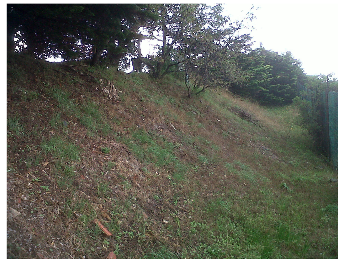
Foto 4: CP Portoferraio, vista della scarpata rinverdata presente lungo il perimetro sud.
