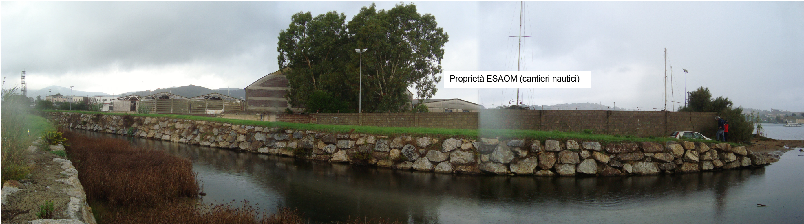
Foto 15: Portoferraio, vista della Foce del Fosso della Madonnina dall'argine artificiale destro in massi ciclopici. Il cavidotto terrestre sarà collocato ad una distanza di 4m dall'argine ed andrà ad interessare la proprietà ESAOM (Cantieri Nautici).
