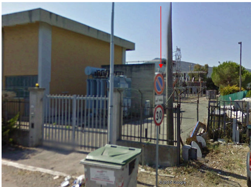
Figura 28: Vista da via della Ferriera (fonte: Google street view) in corrispondenza dell'accesso alla CP Portoferraio. L'intervento non risulta visibile
