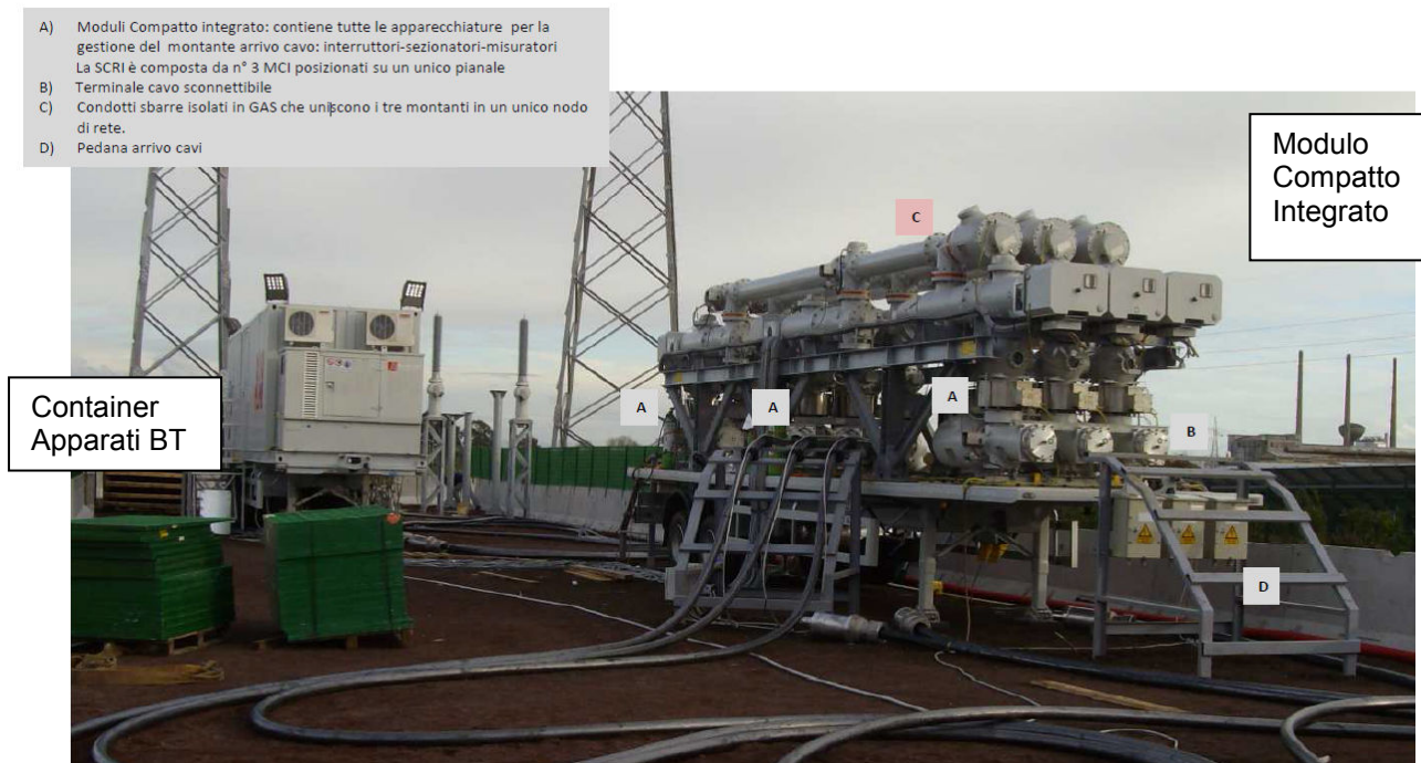
Figura 6: Esempio di Modulo Compatto Integrato
