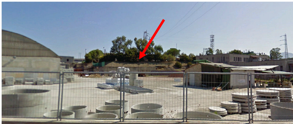
Figura 24: Vista da sud ella CP. La freccia rossa evidenzia la vegetazione arborea della CP che impedisce la visibilità all'interno
