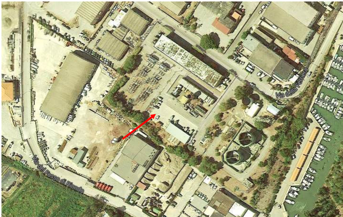
Figura 26: Localizzazione della Stazione di connessione a rapida installazione (indicata in rosso). Si noti la presenza della cortina vegetale e dei fabbricati che costituiscono una schermatura rispetto alle visuali dai principali percorsi stradali
