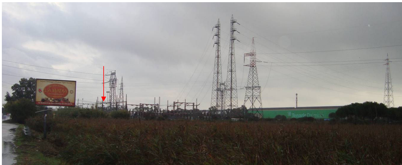
Figura 4.3-4: C.P. Colmata (con la freccia rossa è indicato il punto in cui sorgerà il nuovo sostegno, interno alla CP)
