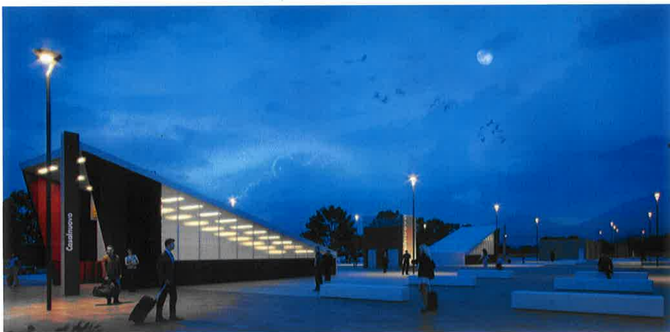
Fig. 25 – Fermata di Casalnuovo
