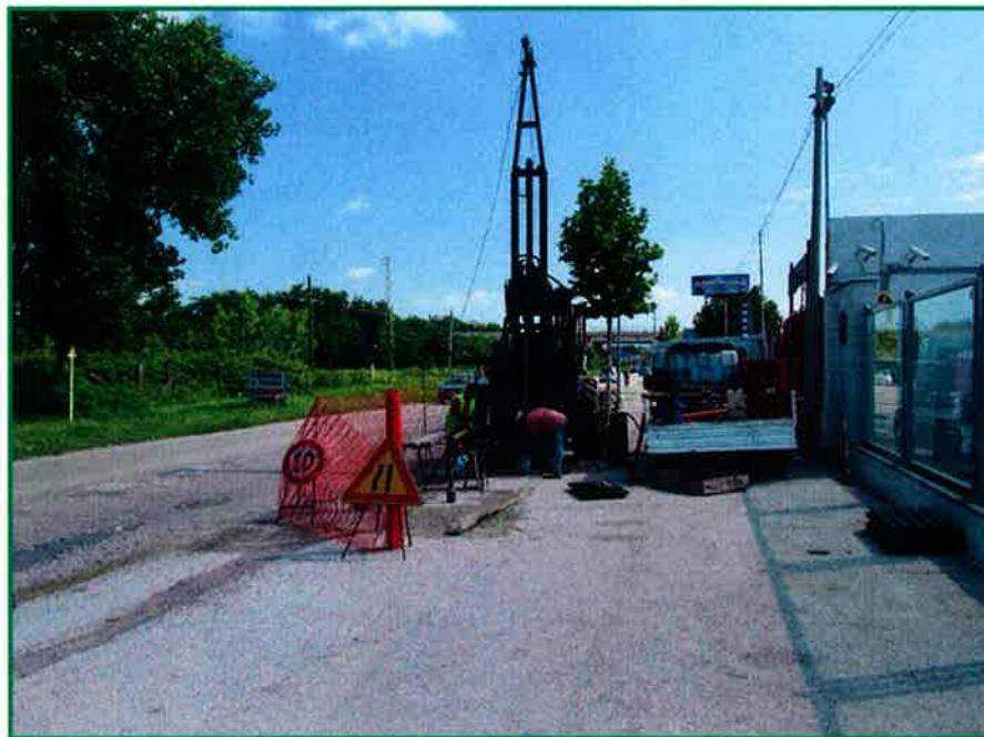
Sondaggio S28_bis: Postazione
