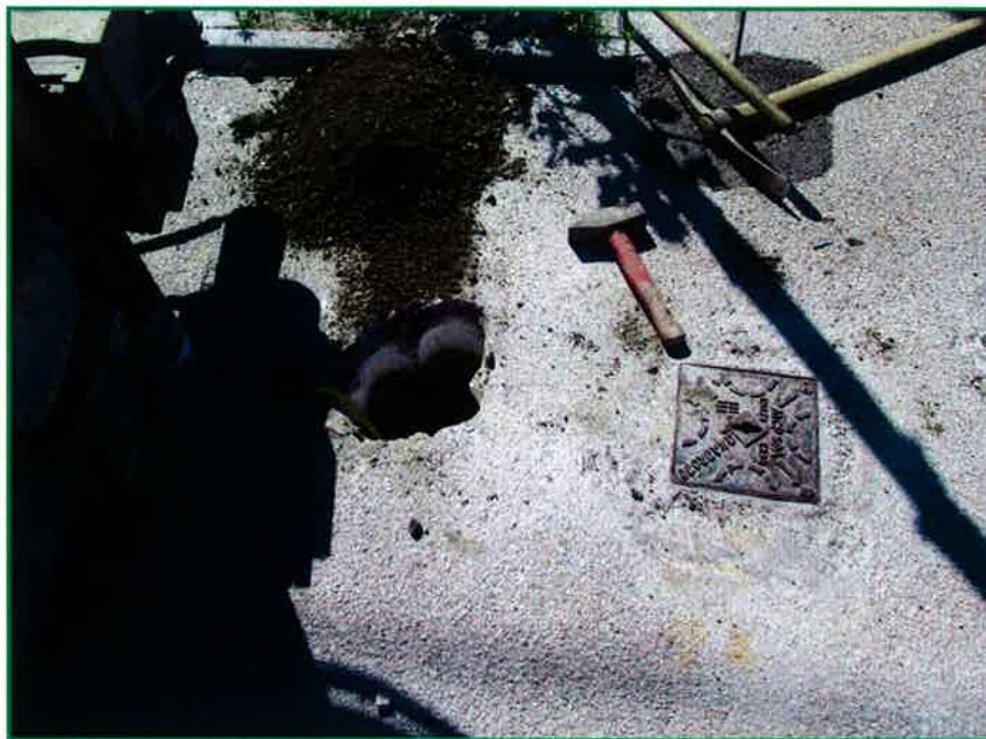
Sondaggio S28_bis: Prescavo
