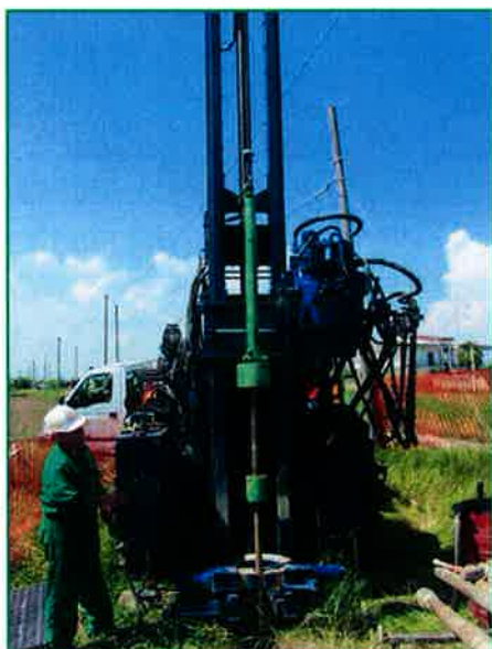
Figura 1: Foto esecuzione prova
