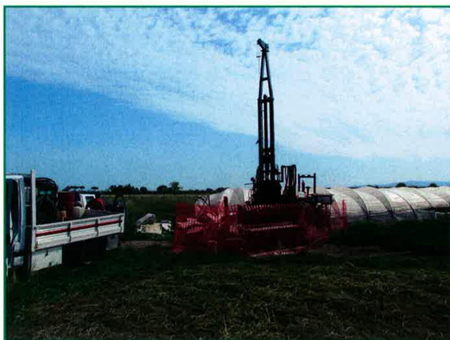
Sondaggio S21_bis: Postazione
