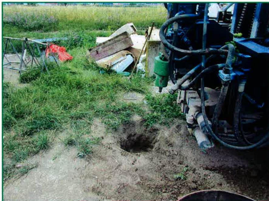
Sondaggio S21_bis: Prescavo
