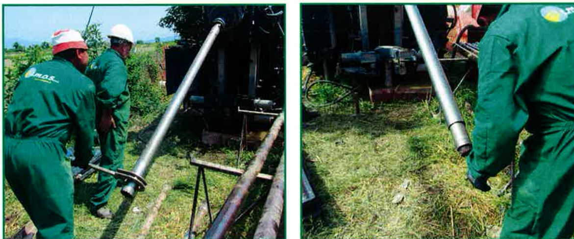
Figura 1: Fasi di utilizzo del doppio carotiere
