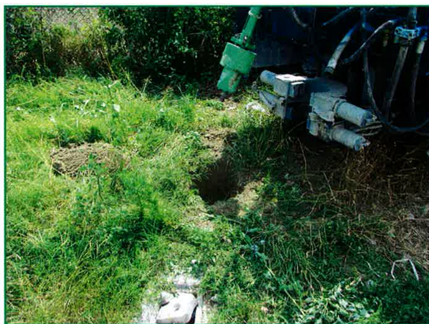
Sondaggio S50_bis: Prescavo
