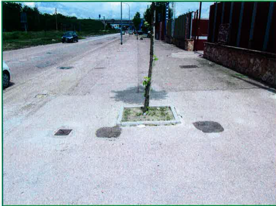
Sondaggio S28_bis: Stato di fatto ante-sondaggio
