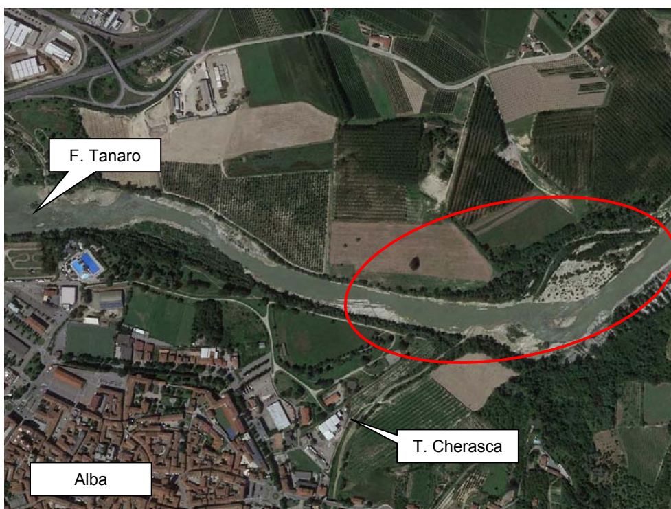
Fig. 1.3 Dettaglio dell'area in cui è prevista la realizzazione dell'impianto idroelettrico in progetto. Fonte: Google Earth, 2013 (immagine non in scala).
