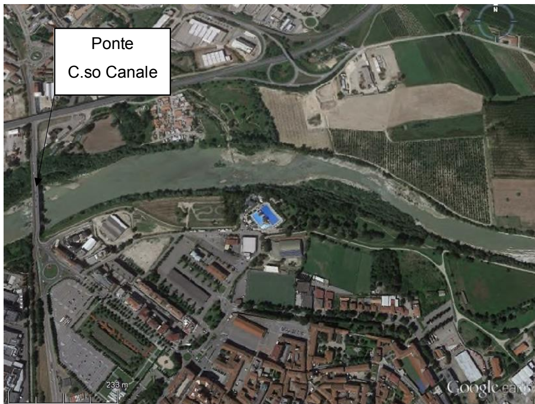
Figura 4.1 – Immagine del 08/10/2013 (Google Earth, 2015), del tratto a monte dell'intervento.
