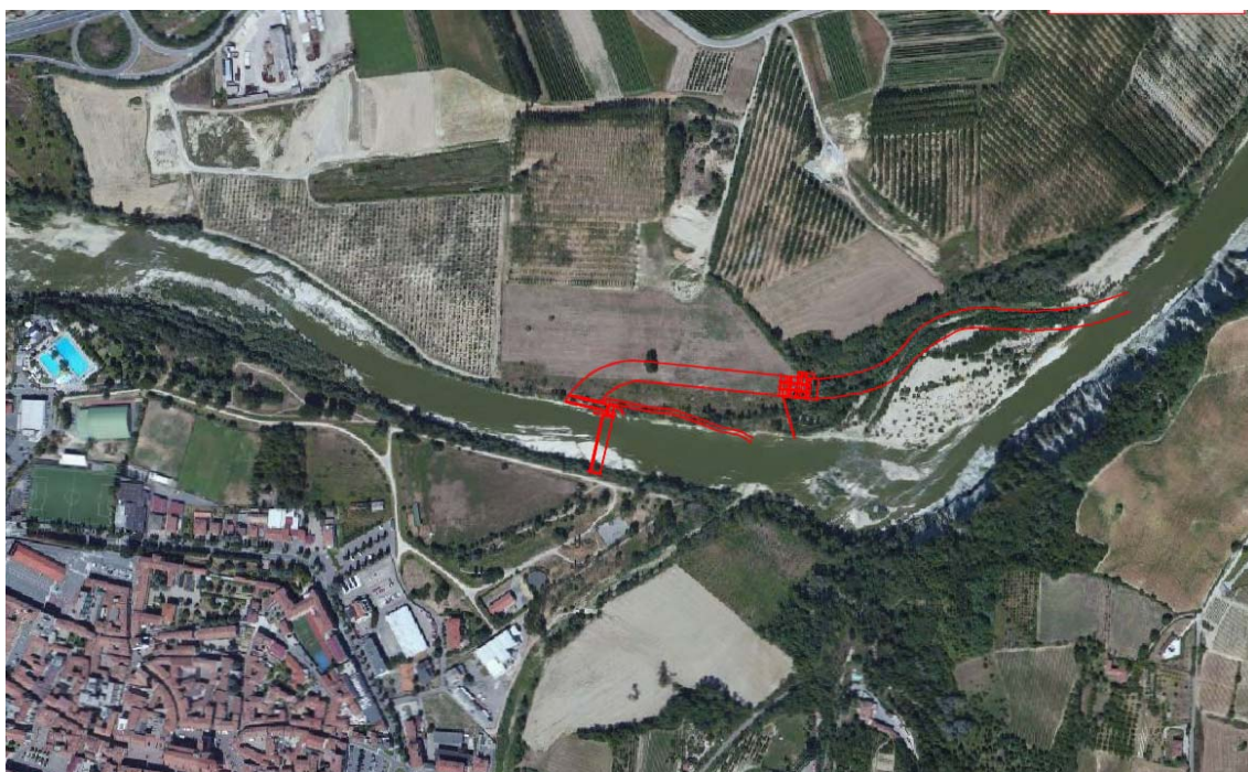
Fig. 8.2: Fotografia aerea con localizzazione dell'impianto in progetto.
