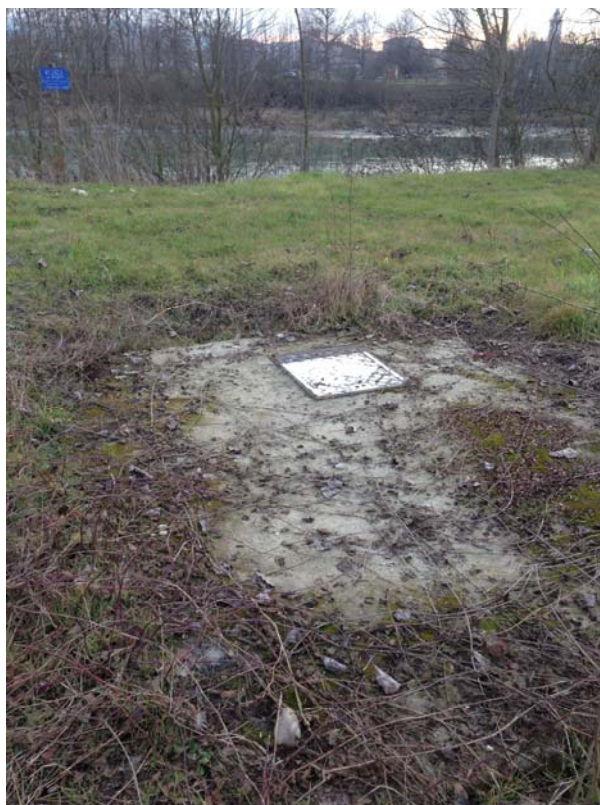
foto 4: pozzetto esistente del SISI
