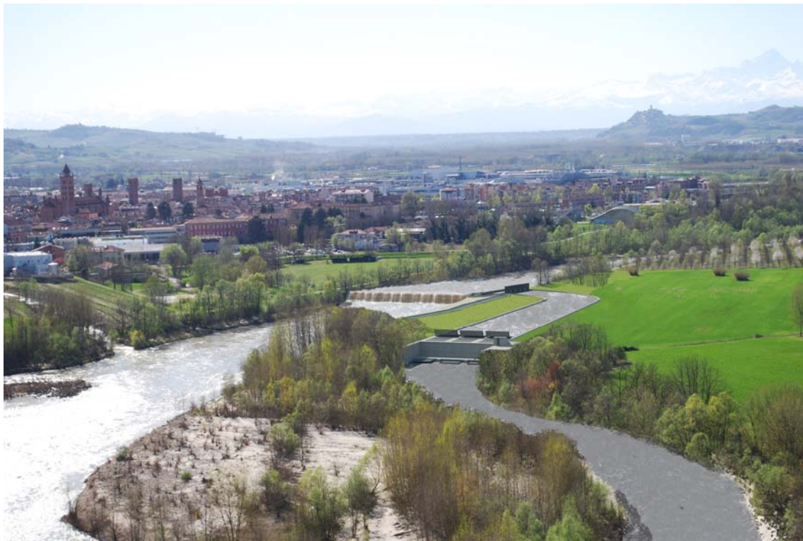
Fotoinserimento 1: vista panoramica dell'impianto in progetto
