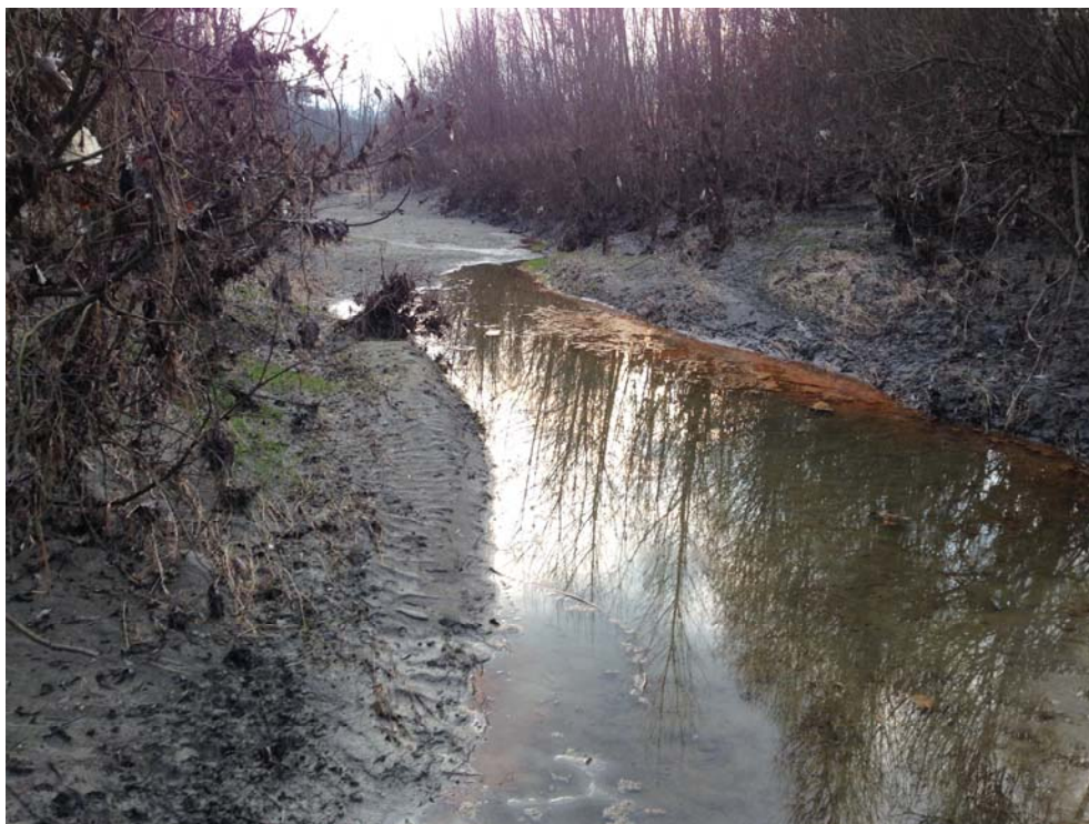
foto 11: vista da monte verso valle del canale esistente in sponda sinistra che si prevede di utilizzare, dopo un opportuno adeguamento della sezione idraulica, come canale di scarico.
