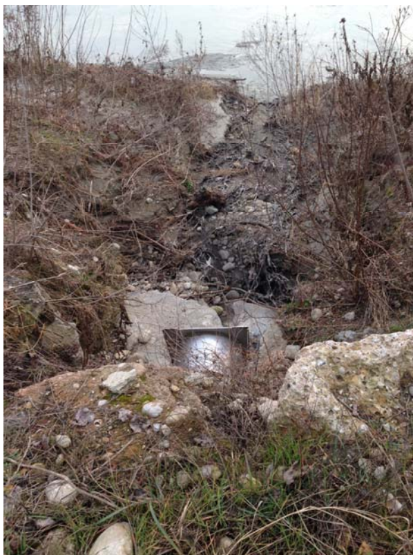
foto 2: scarico in Tanaro dello sfioratore del SISI
