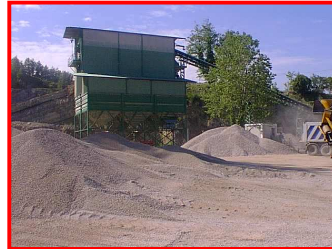
– PIAZZALE DI LAVORO – (CAVA N° 4)
