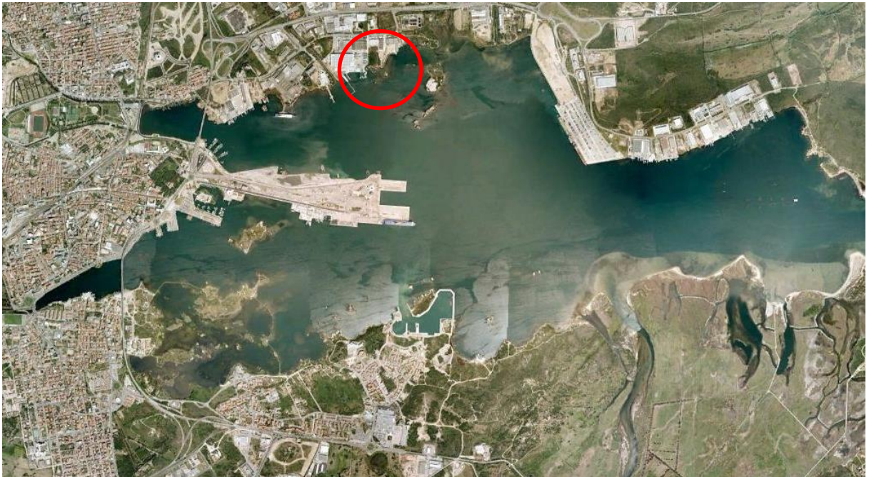
Figura 1: Vista aerea della zona interessata dal progetto.
