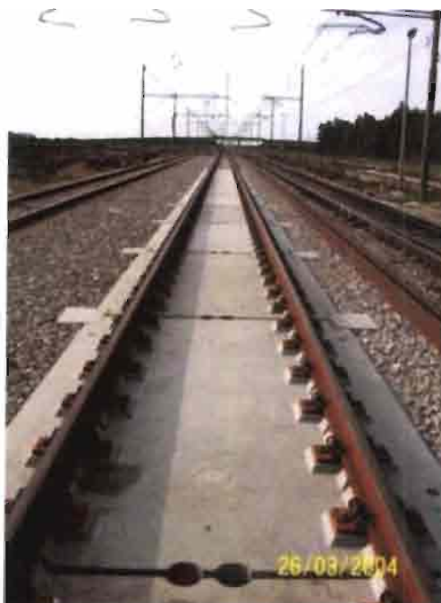
Figura 41 - MAX BÖGL – HIPERTRACK – MASS – SPRING SYSTEM h = 500 mm con materiale elastomerico sotto platea
