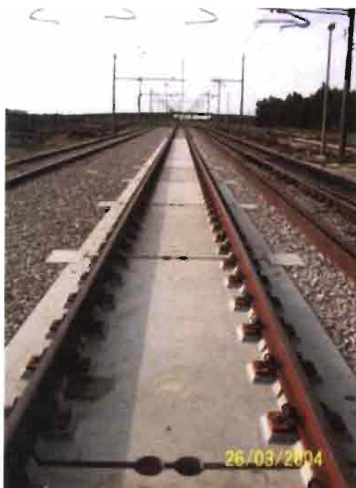
Abbildung 41 - MAX BÖGL – HIPERTRACK – MASS – SPRING SYSTEM h= 500 mm mit Elastomer-Material unter der Plattform
