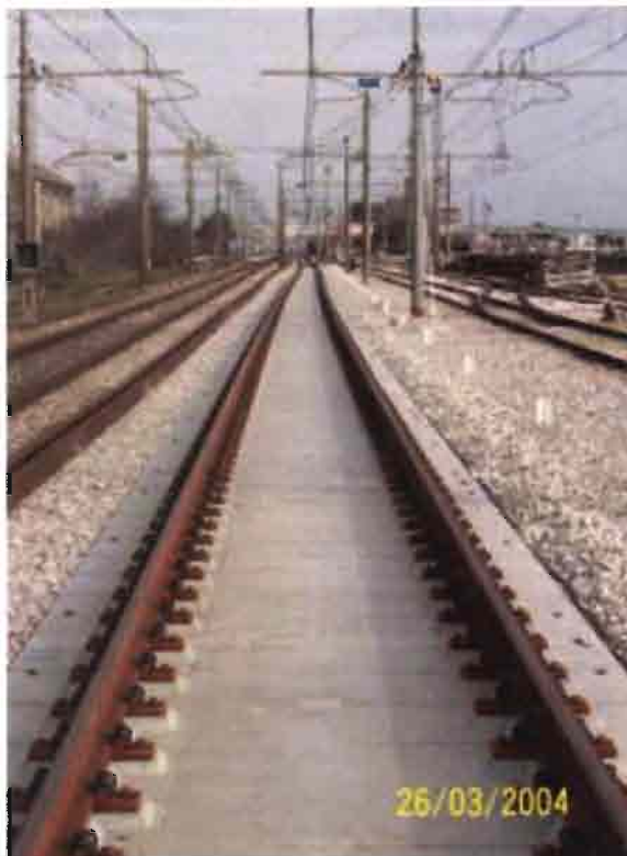
Abbildung 42 - MAX BÖGL – HIPERTRACK – SLAB - TRACK SYSTEM ( h = 200 mm )
