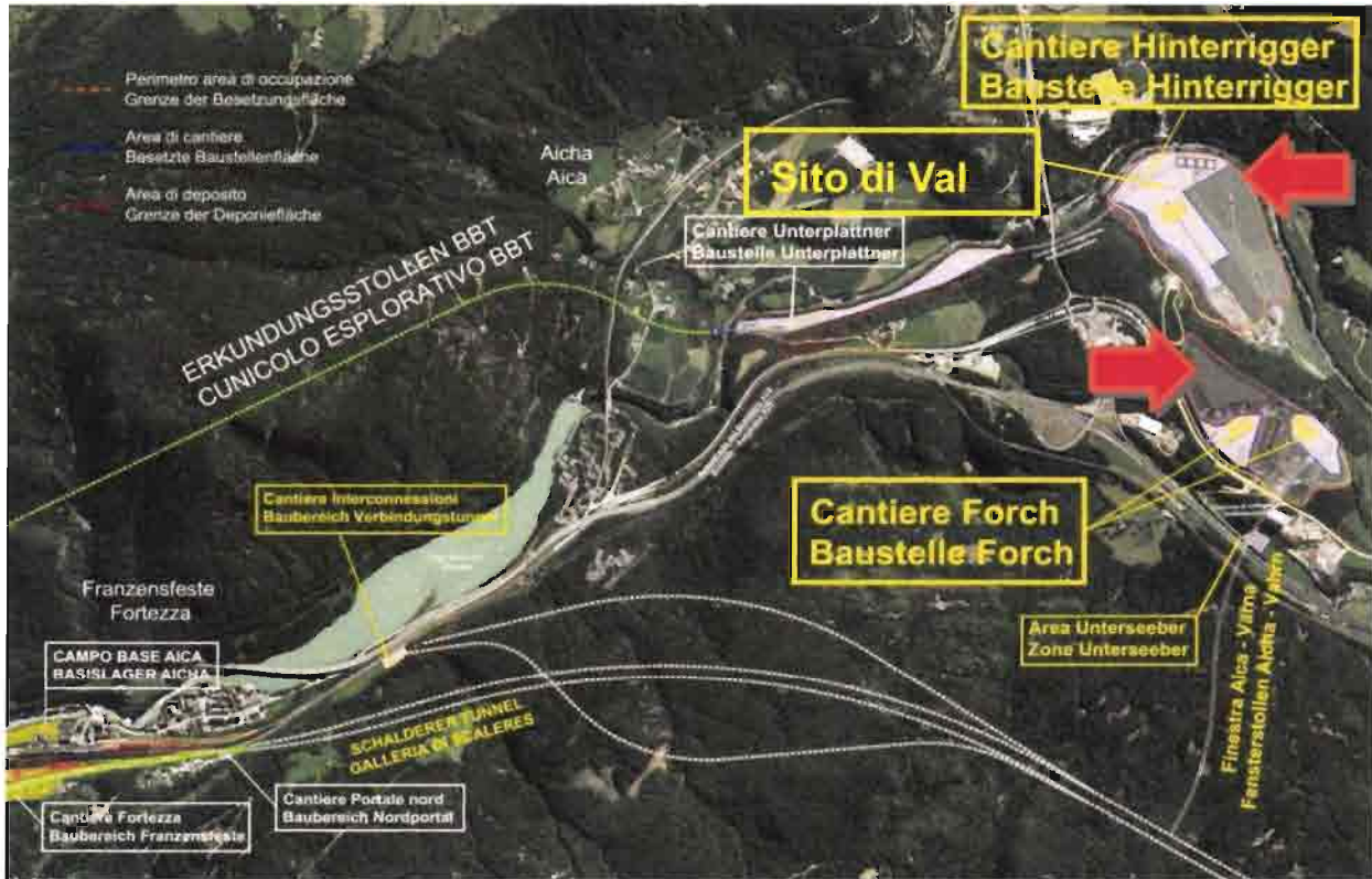
Abbildung 12 - Baustellenumgebung im Riggertal – Überblick der Gebiete Unterplattner – Hinterrigger und Forch (aus dem Überprüfungsbericht des Projekts für den Basistunnel)
