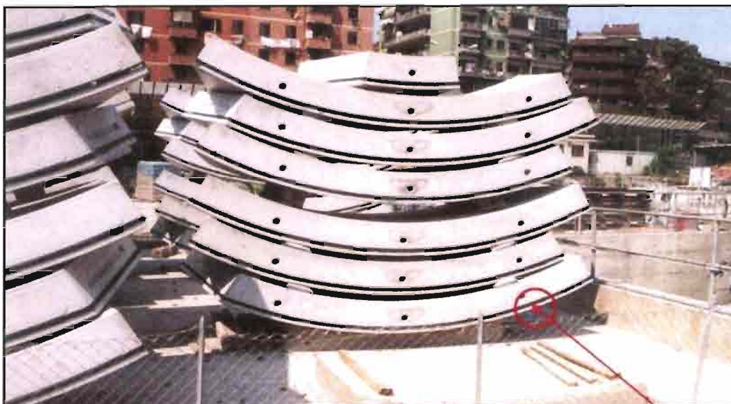
Figura 11.44 - Conci prefabbricati con guarnizioni in neoprene a tenuta idraulica
