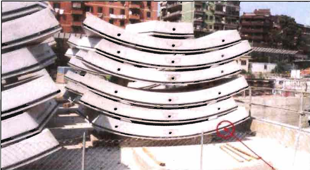
Abbildung 11.44 – Vorgefertigte Tübbings mit wasserhaltenden Neoprendichtungen
