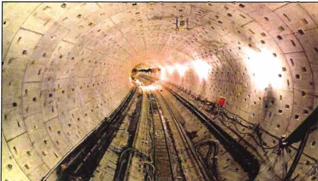
Abbildung 11.45 – Auskleidung mit vorgefertigten Tübbings
