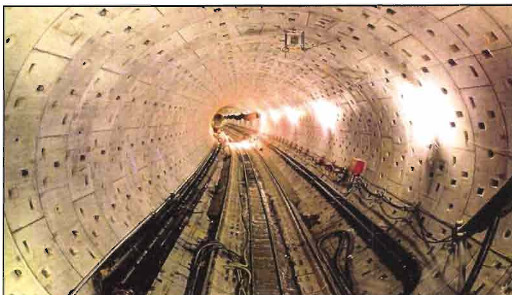
Figura 11.45 - Rivestimento in conci prefabbricati
