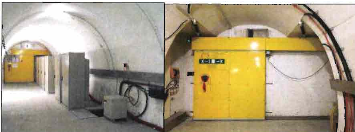
Abbildung 11.11 - Innenansicht Querschläge und Schiebetür im Querschlag
