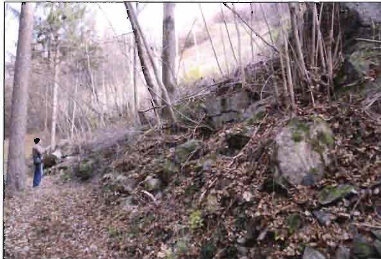
Fig. 15-6 Frana di crollo costituita esclusivamente da filladi quarzifere.
