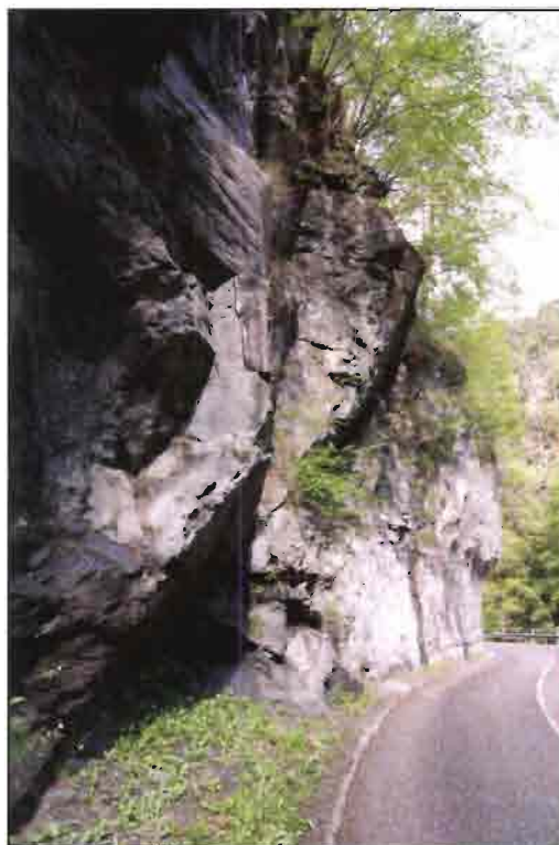
Fig. 15-55 Particolare del piano di faglia.
