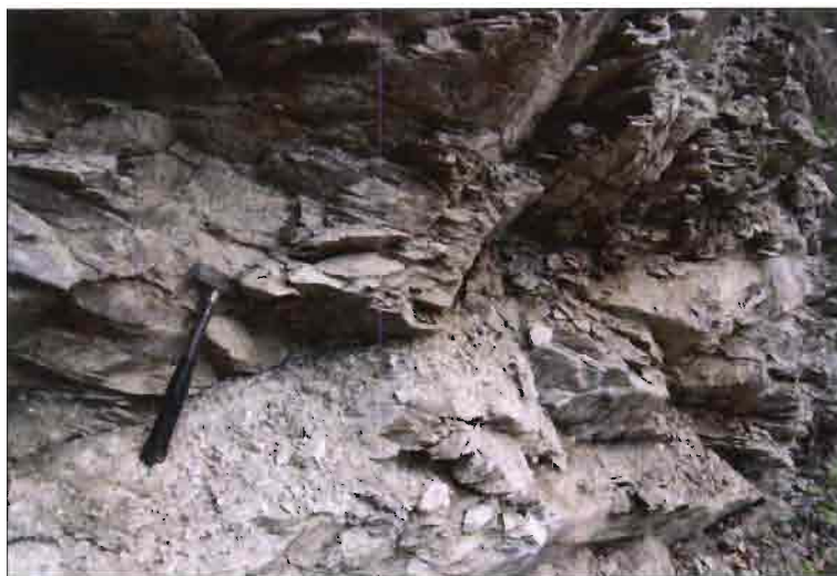
Fig. 15-51 Particolare del piano di faglia.
