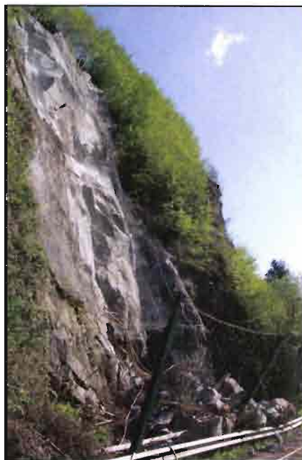
Fig. 15-60 Paramassi parzialmente deformato da frana di crollo su anfiboliti erciniche.
