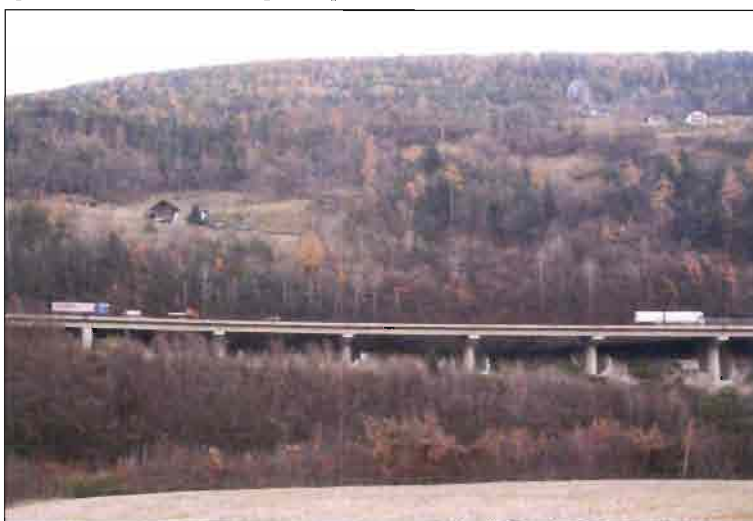
Fig. 15-1 Area con fenomeni morfologici di tipo gravitativo, viadotto A22 a nord di Ponte Gardena.
