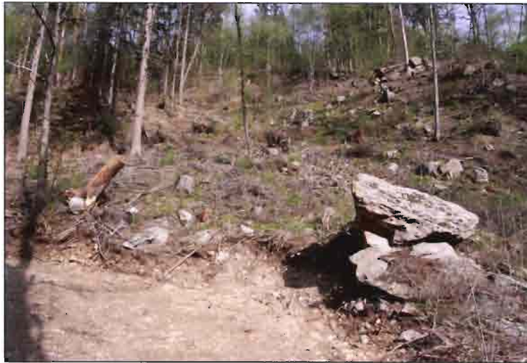
Fig. 15-40 Particolare del corpo di frana.
