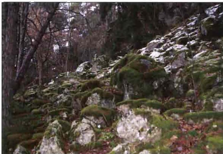
Fig. 15-31 Corpo di frana per crollo.
