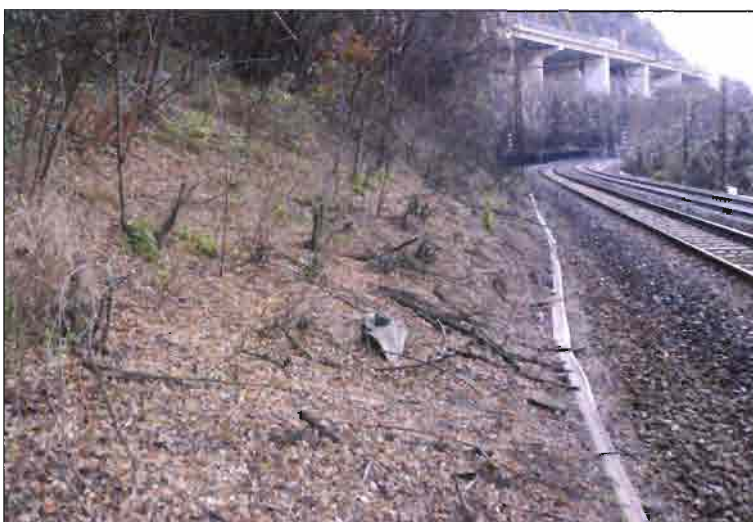
Fig. 15-2 Settore a valle del viadotto A22, nord di Ponte Gardena, nessun elemento visibile di instabilità attiva.
