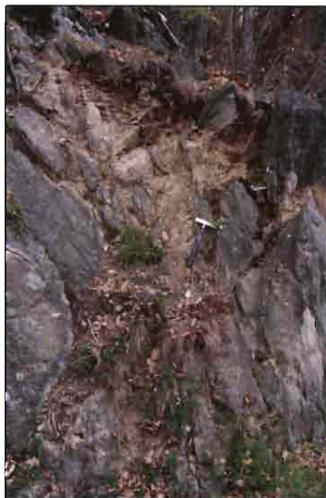
Fig. 15-45 Particolare del riempimento costituito da depositi fluvio-glaciali.
