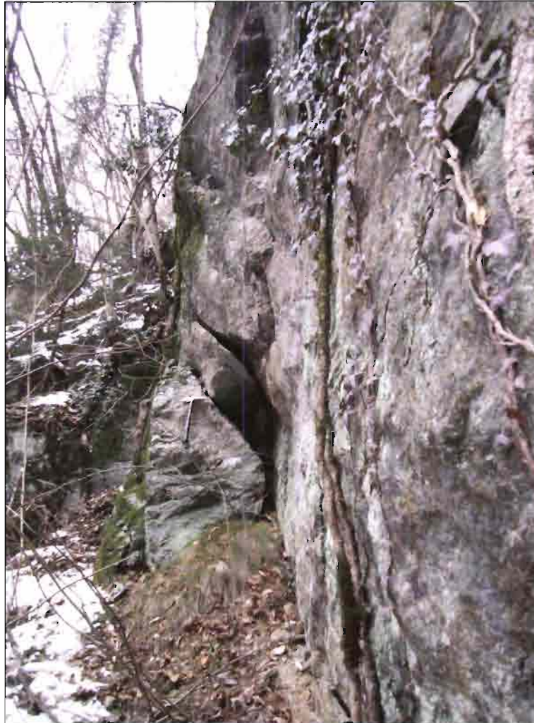
Fig. 15-32 Particolare della frattura sub-verticale.
