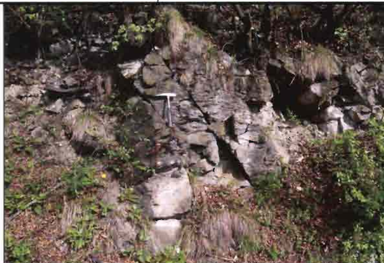
Fig. 15-38 Particolare dei due sistemi di frattura principali.
