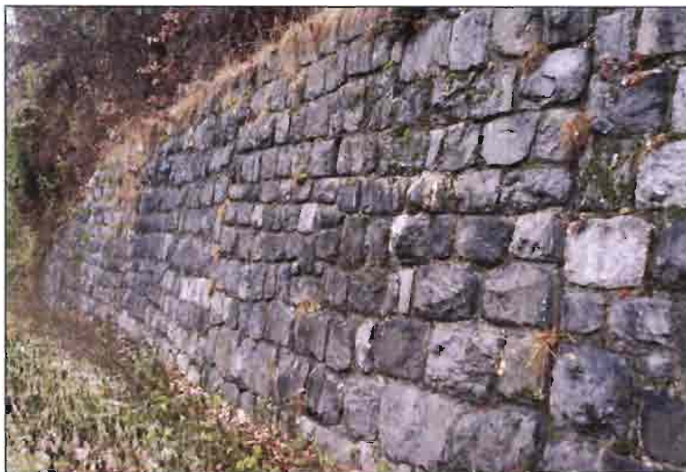
Fig. 15-15 Nord di Ponte Gardena, opere di difesa dei versanti all'interno dell'area in frana; non sono visibili elementi riconducibili a movimenti attuali.
