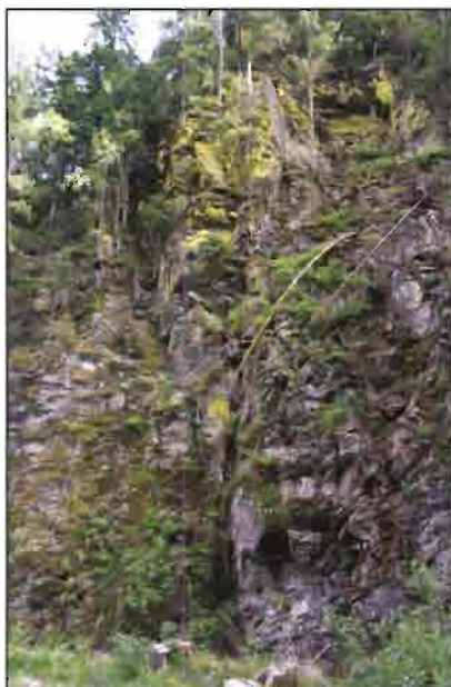
Fig. 15-78 Particolare del cuneo roccioso creato dalla presenza di due sistemi di frattura a dimensione pluridecimetrica.
