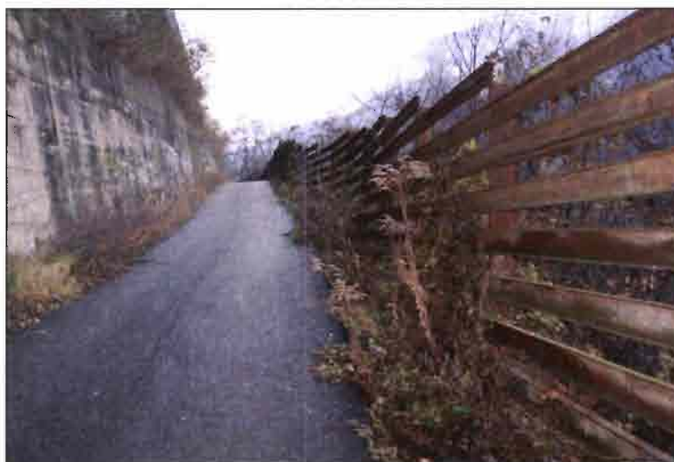
Fig. 15-22 Strada di servizio sottostante alla A22, località Ponte Gardena.
