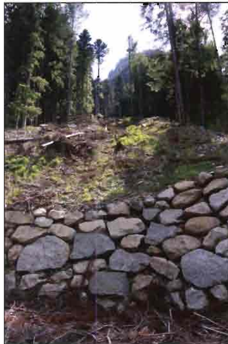
Fig. 5-71 Particolare delle difese di versante
