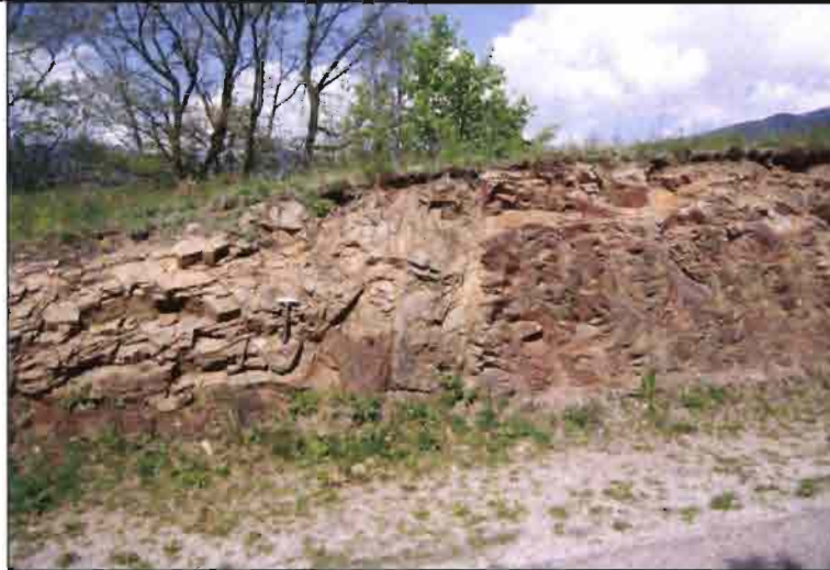
Fig. 5-64 Particolare delle faglie minori che rigettano il contatto tra le due rocce.
