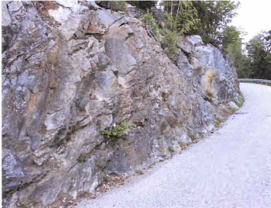
Panoramica stazione geostrutturale 1N nelle Filladi di Bressanone.
