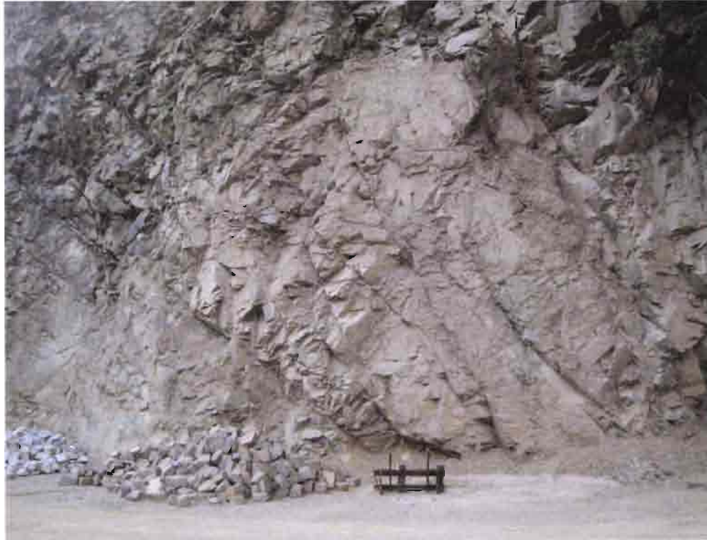
Panoramica affioramento ammasso roccioso (BR29) presso cava a nord di Chiusa.
