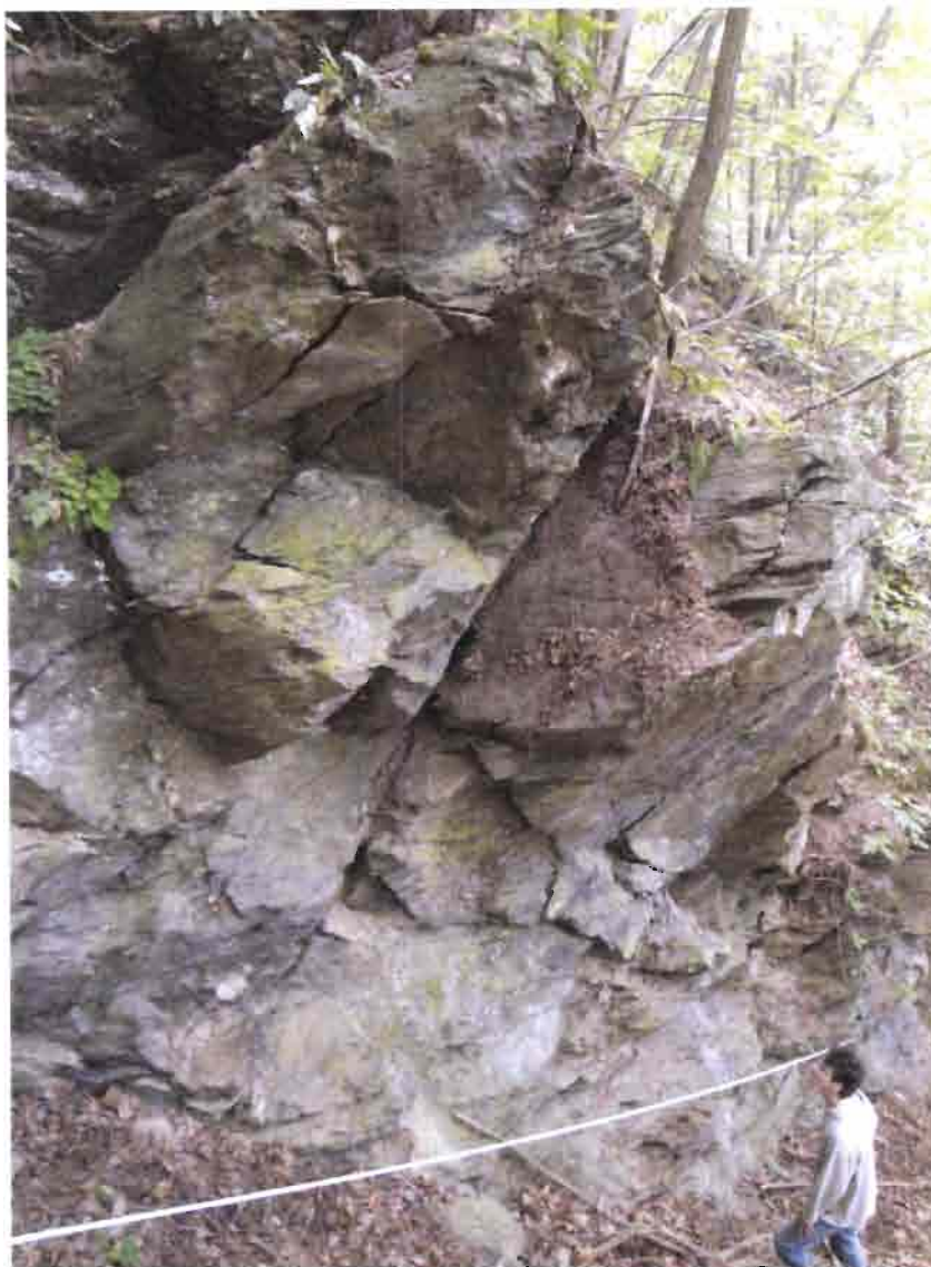
Panoramica affioramento ammasso roccioso (Br21) costituito da filladi quarzitiche.
