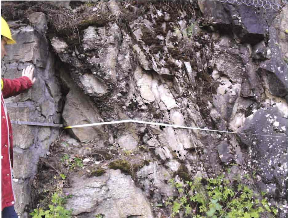
Panoramica stazione geostrutturale 23N nella formazione dei Graniti di Bressanone
