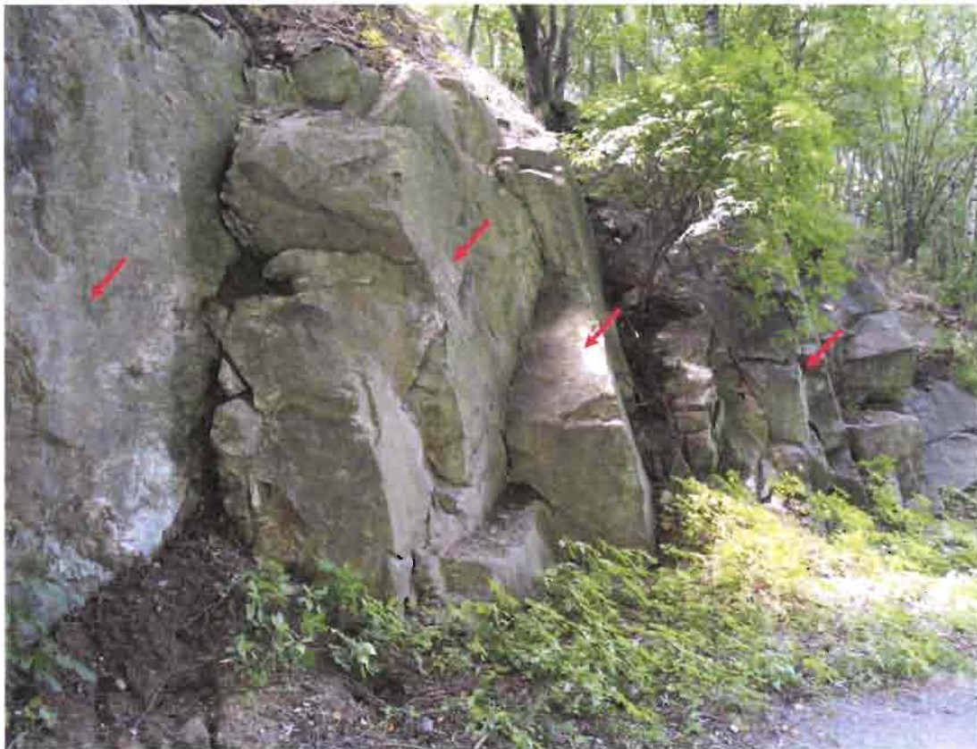
Figura 3 - Panoramica affioramento di granito presso Fortezza. Le frecce evidenziano le discontinuità sub-verticali immergenti verso Nord (Stendimento 4 N).
