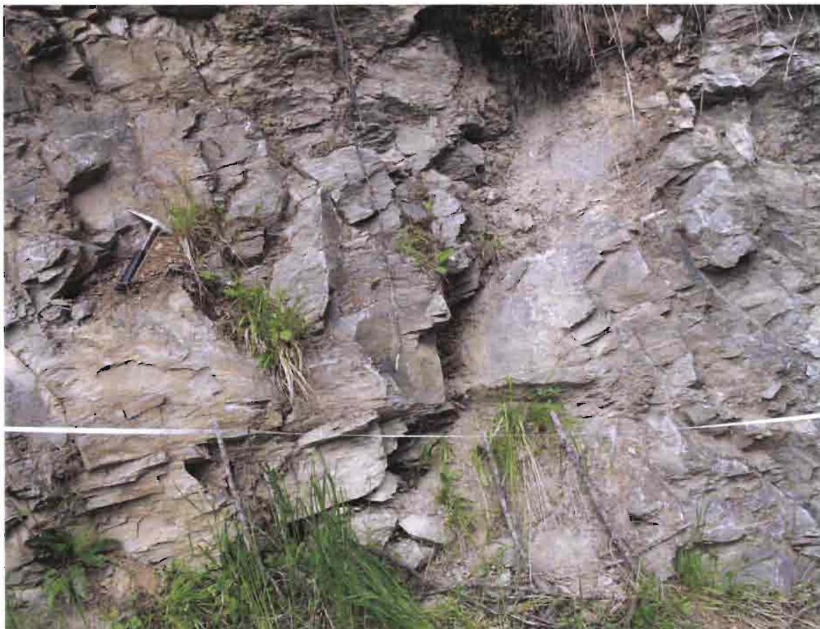
Panoramica stazione geostutturale 22N nella formazione delle Filladi di Bressanone
