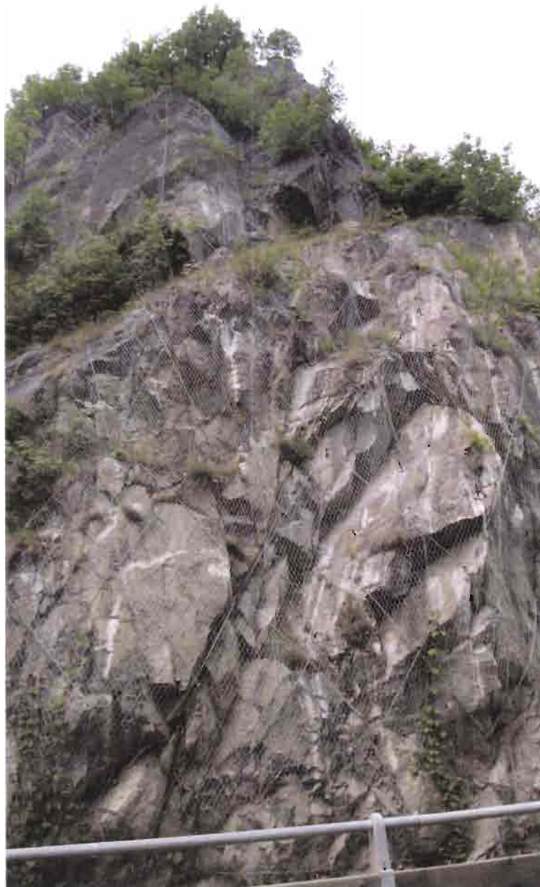
Panoramica stazione geostrutturale BR03 nelle Dioriti di Bressanone
