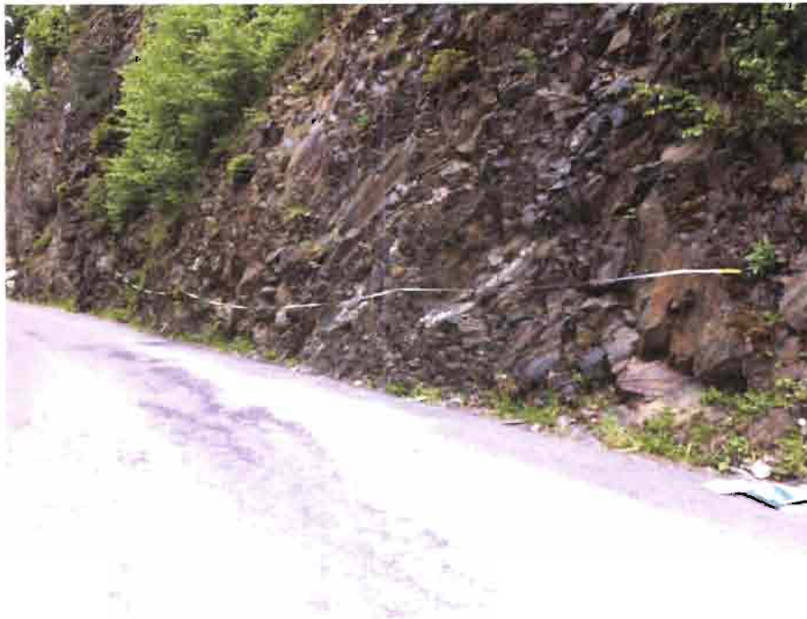
Stazione geostrutturale 3N presso Spelunca, panoramica affioramento di filladi.
