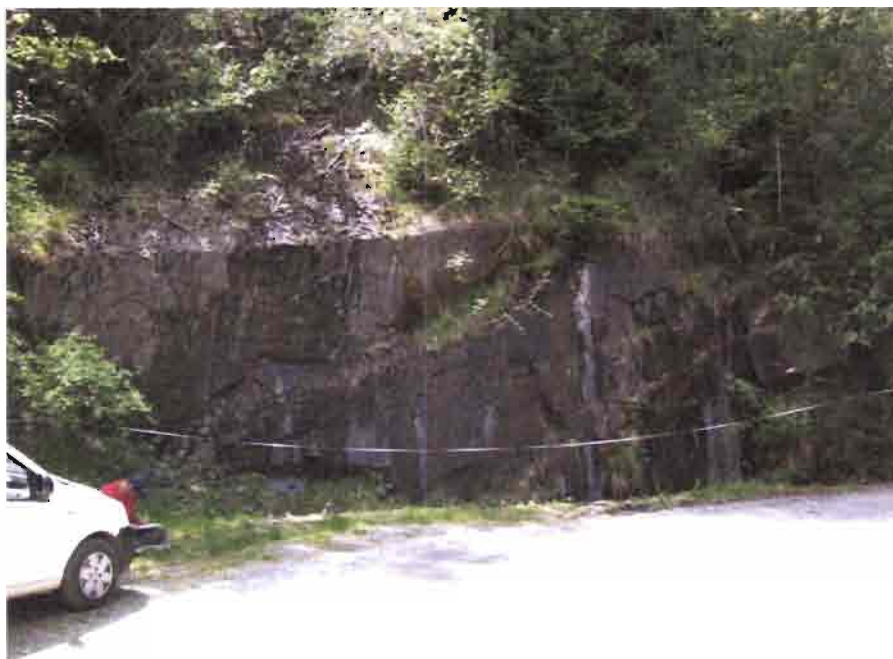
Panoramica stazione geostrutturale 10N nelle formazioni delle Cornubianiti di Bressanone.
