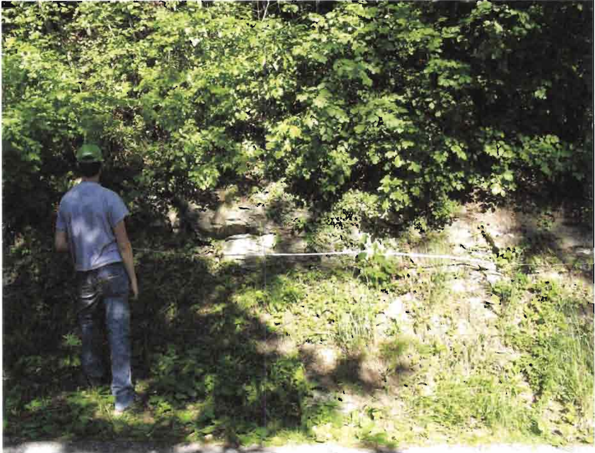
Stendimento BR13 presso Ponte Gardena, panoramica affioramento di filladi.
