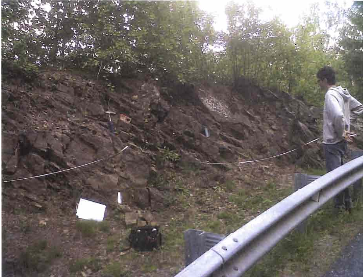
Dettaglio affioramento ammasso roccioso (Br25) costituito da filladi.
