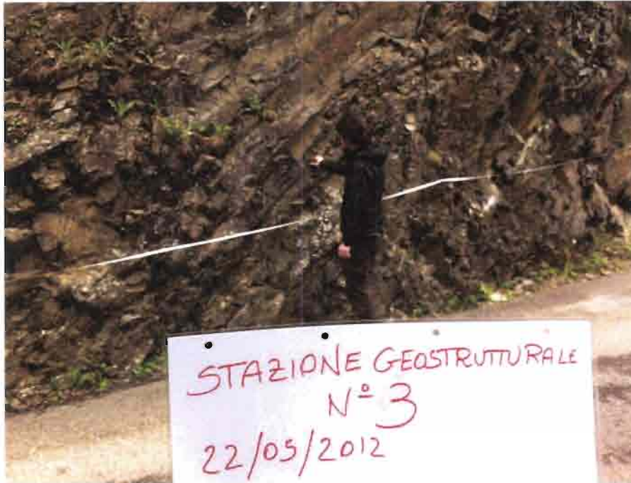
Panoramica stazione geostrutturale 3N.
