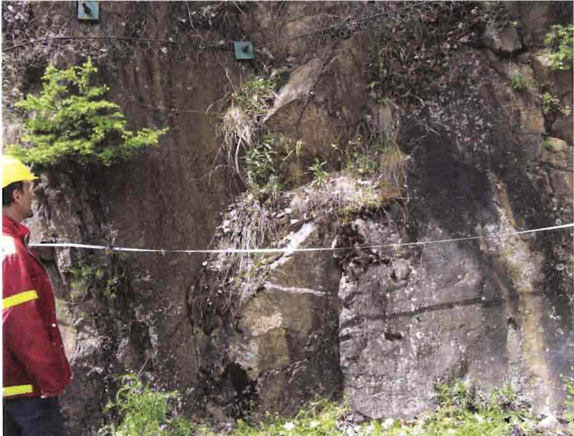
Panoramica stazione geostrutturale 24N nella formazione dei Graniti di Bressanone
