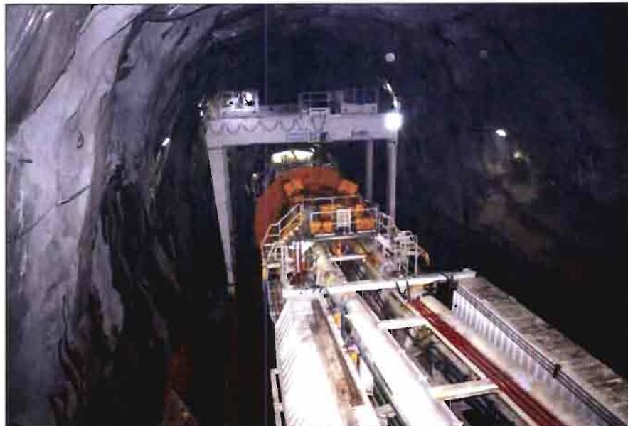
Fig. 12.12- Camerone di lancio per una TBM (galleria S.Gottardo).
