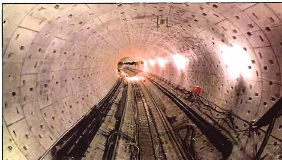
Fig. 12.6 – Rivestimento in conci prefabbricati
