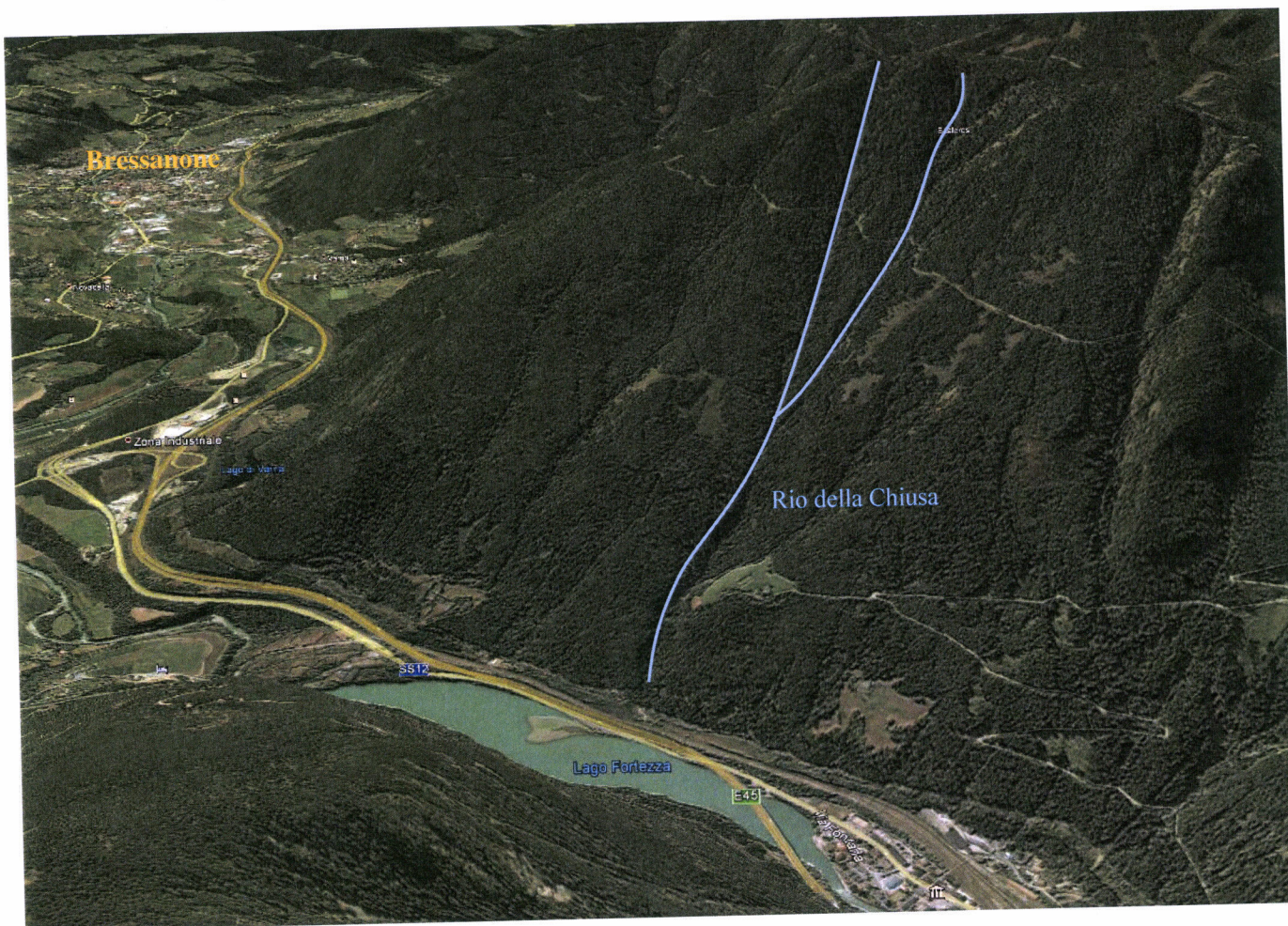
Figura 1 – Vista verso sud del bacino del Rio della Chiusa e del lago di Fortezza (fonte Google Earth).
