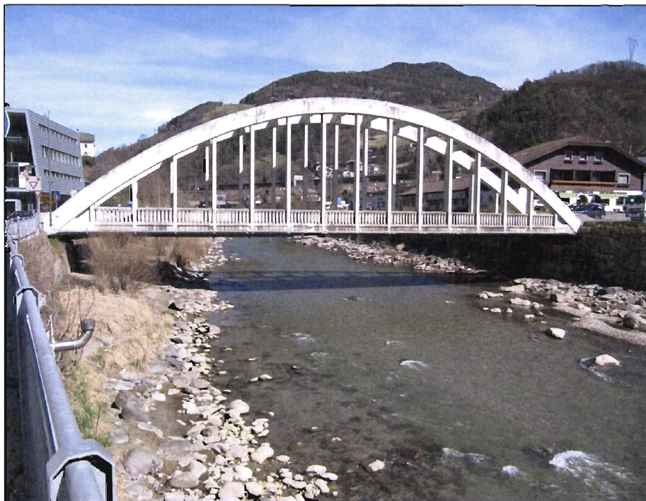
Figura 4 – Ponte stradale di via Isarco
