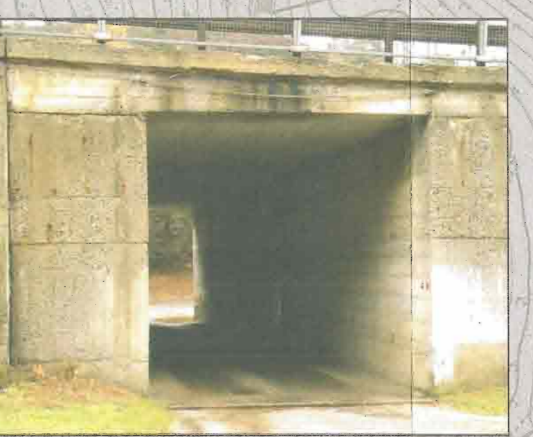
FOTO 6 - SOTTOVIA ESISTENTE h=3,00m
