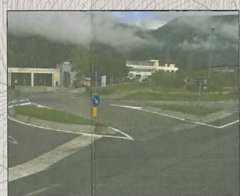
FOTO 1 - VISTA STRADA DI ACCESSO AI CANTIERI OPERATIVI
