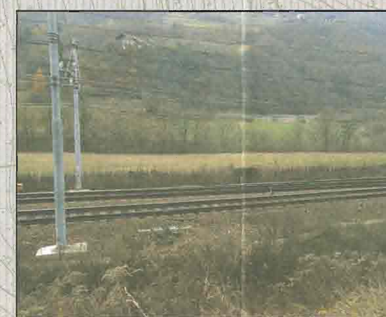
FOTO 2 - VISTA DELL'AREA DESTINATA AL CANTIERE OPERATIVO CO.06A
