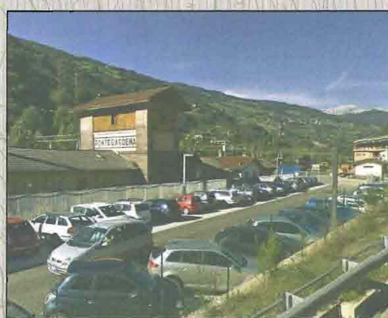
FOTO 1 - VISTA DELL'AREA DESTINATA AL CANTIERE OPERATIVO CB.05
