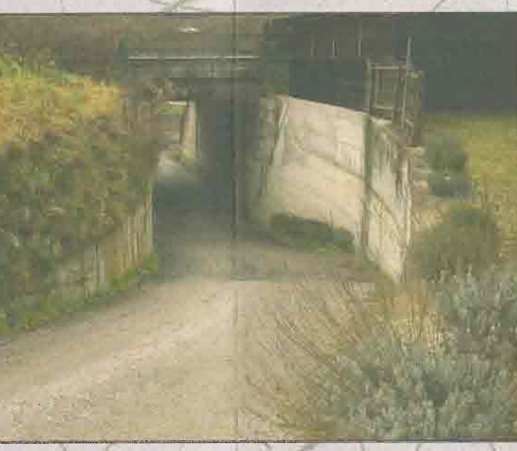
FOTO 5 - SOTTOVIA ESISTENTE PER ACCESSO AL CANTIERE BASE C.B.04
