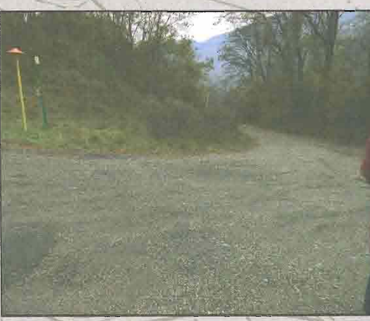
FOTO 4 - VISTA DEVIAZIONE STRADA STATALE 242dir.
